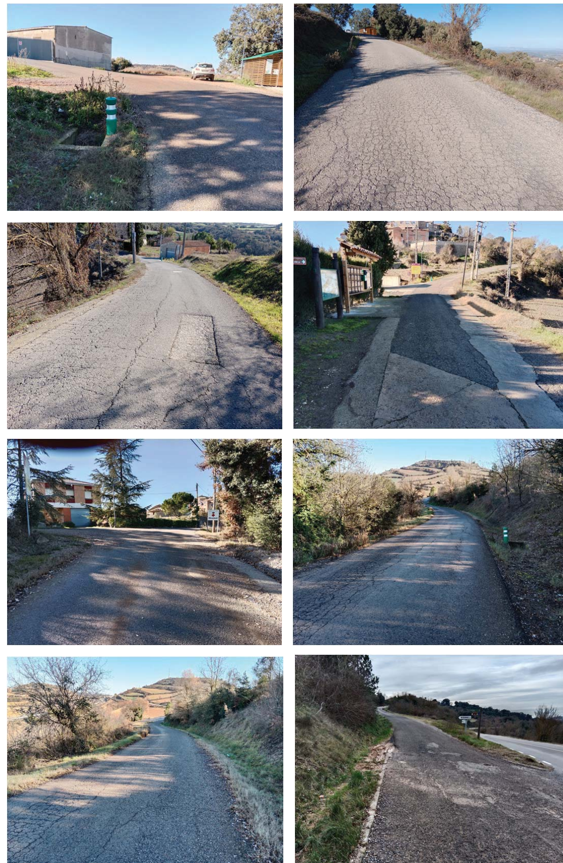
Imatges 1 a 8: de pq 0+425 a pp 0+000
