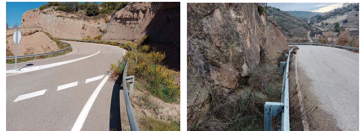
Imatges 1 i 2: de pq 0+000 a pq 0+200. Cunetó per desbrossar.
