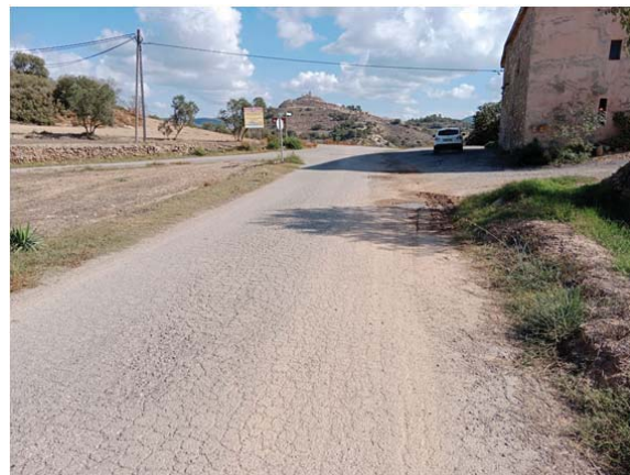
Imatges 3 a 8: de pq 0+200 a pq 0+950. paviment amb flonjalls i defectes d'aglomerat
