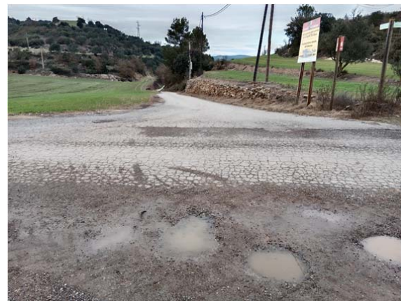
Imatges 3 a 8: de pq 0+200 a pq 0+950. paviment amb flonjalls i defectes d'aglomerat
