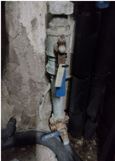
Imatge 4: entrada de l'escomesa d'aigua soterrada a l'Estadi i Imatge 5: connexió consums d'aigua
