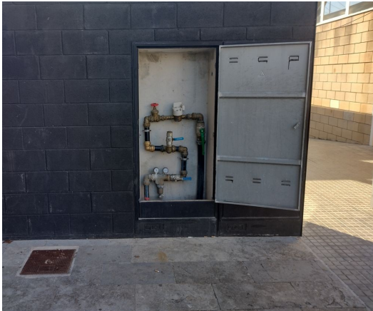
Imatge 6: Armari alimentació d'aigua
