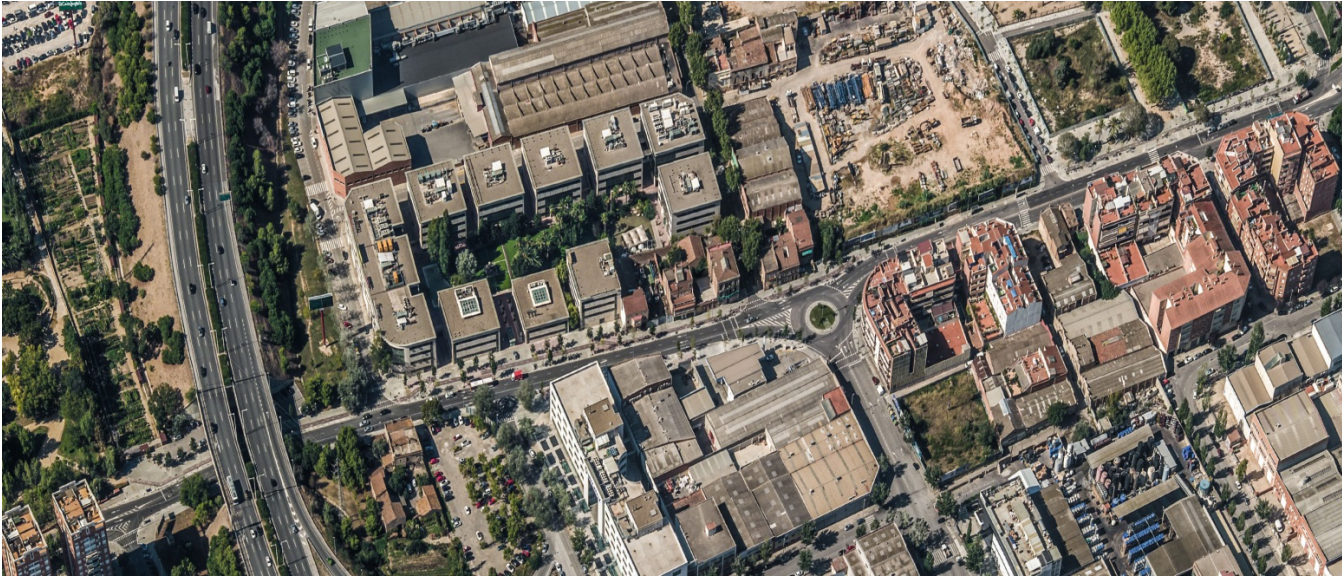
Situació prèvia, vista aèria.
