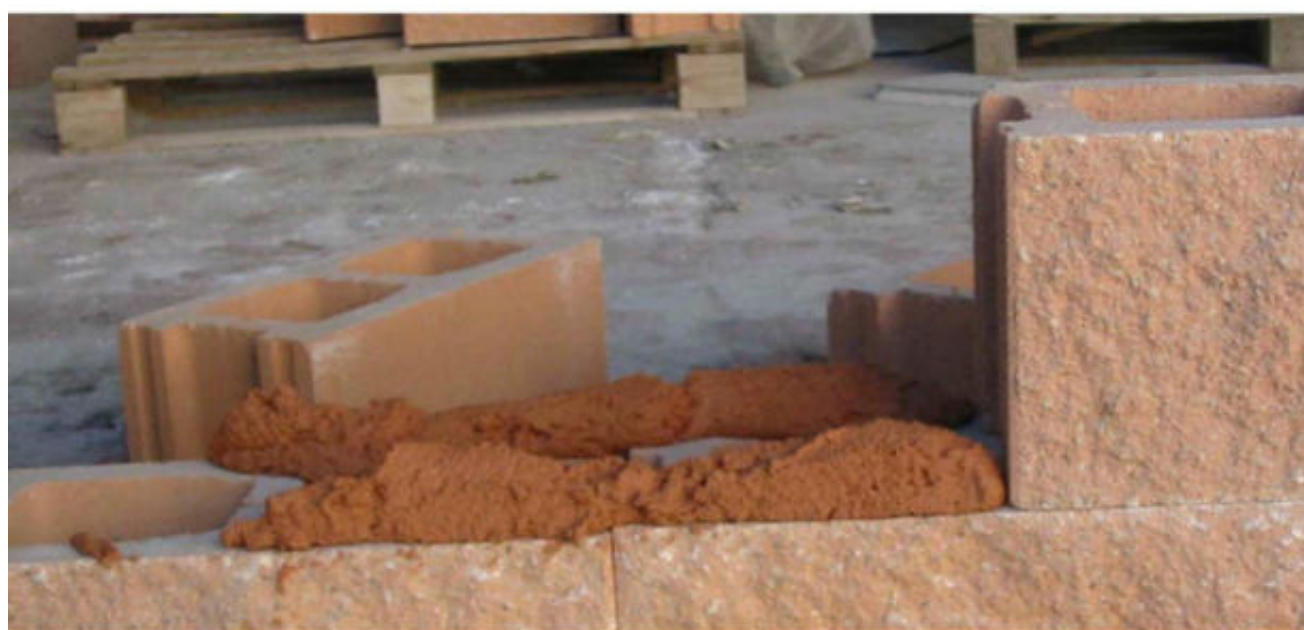
Figura 1. Colocación de bloques con mortero de albañilería
