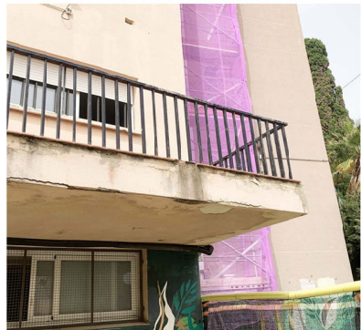
Detall del cantell del forjat i arrebossat de sostre de la terrassa
