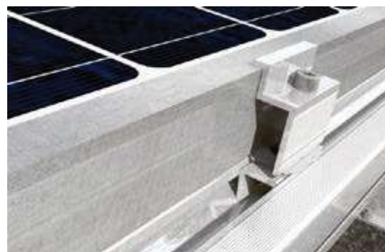
Detalle de la fijación de paneles fotovoltaicos
