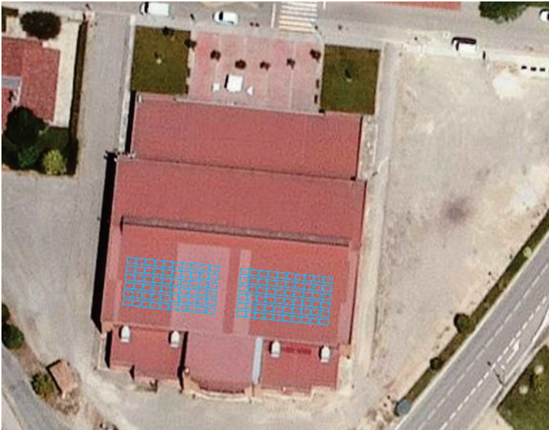
Imatge 1 Vista aèria de la coberta.
