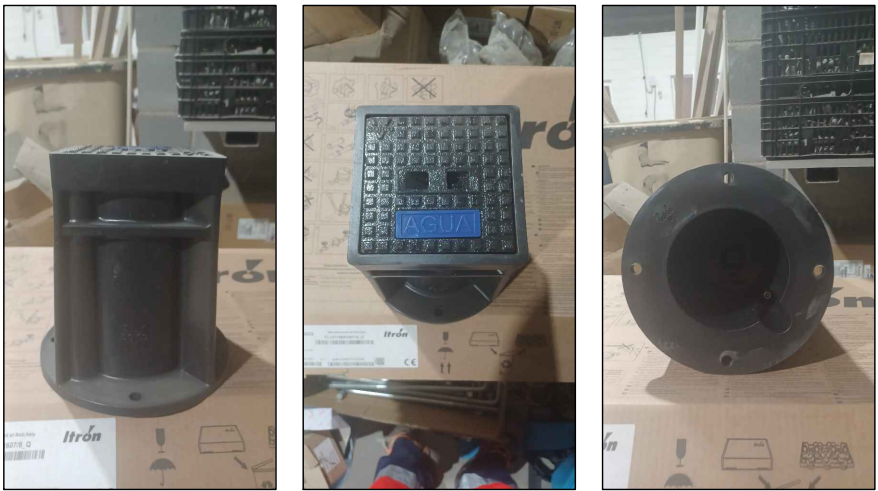
DETALL BASTIMENT CLAUS DE TALL -SERVEI D'AIGUA MONTMELÓ-
