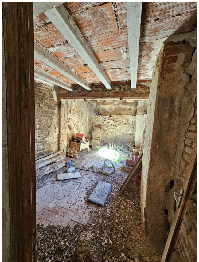
Estances a l'última planta sota coberta. Estat del sostre de cabirons, parts ensorrades. Existeixen parts amb sostre de biguetes de formigó i encadellat ceràmic
