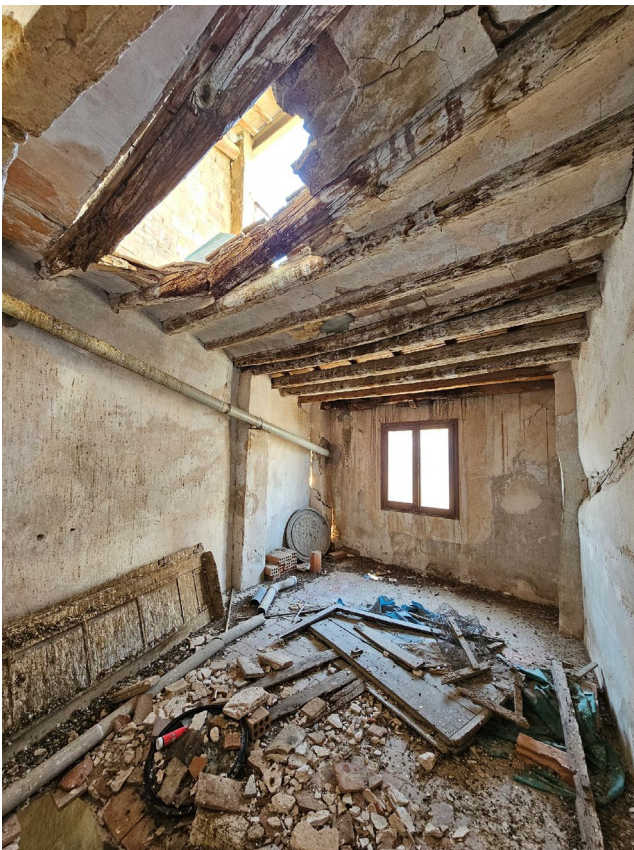
Estances a l'última planta sota coberta. Estat del sostre de cabirons, parts ensorrades. Existeixen parts amb sostre de biguetes de formigó i encadellat ceràmic
