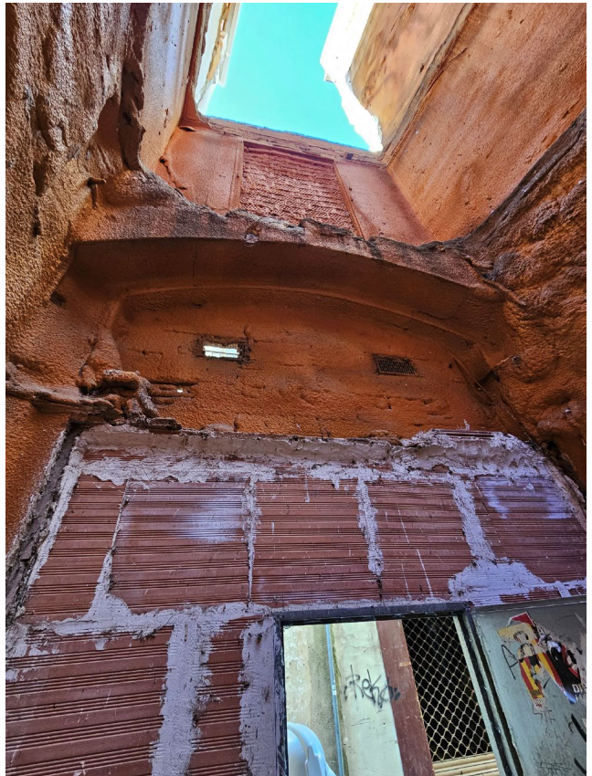
Estat actual del solar amb els cabirons de fusta i el volum edificat al fons i vista interior de la façana.
