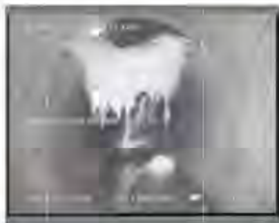
Figura 12: Entrada d'aigua blanca dins la xarxa. Tram 78 entre els pous de registre 65E i 65F
