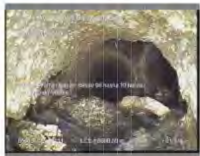
Figura 6: Falla estructural del col·lector. Tram Inspecció 45 entre pous de registre 712 - 773
