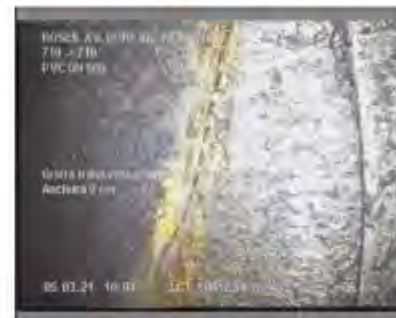
Figura 8: Fieura longitudinal. Tram Inspecció 53 entre els pous 719 i 718
