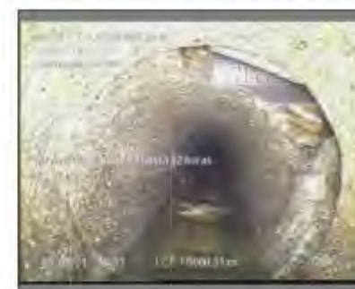
Figura 60: Col·lector amb filtracions a les seves juntes i avançant estat de deteriorament entre pous de registre 773 - 7015
