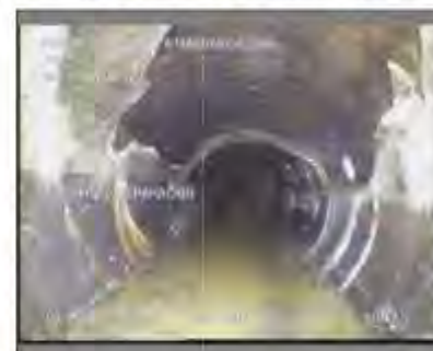
Figura 7: Col·lector trencat sense falla estructural del terreny. Tram Inspecció 50 entre pous de registre 712 - 772
