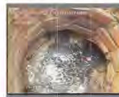
Figura 11: Infiltracions en pou de registre d'obra de fàbrica. Pou 354
