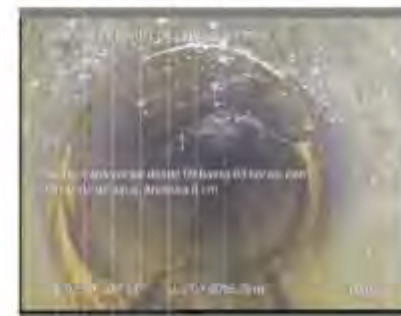
Figura 73. Col·lector amb fissura longitudinal entre pous de registre 502 - 466
