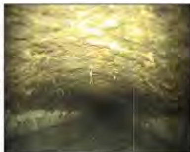
Foto: 69_1_1_10032021_094455_A.jpg 0m, Inicio de la inspección
