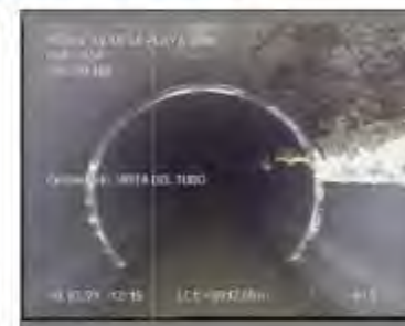
Figura 54: Fissura longitudinal entre els pous de registre 660 - 658
