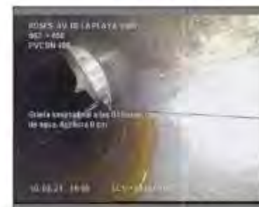
Figura 54: Fissura longitudinal entre els pous de registre 660 - 658
