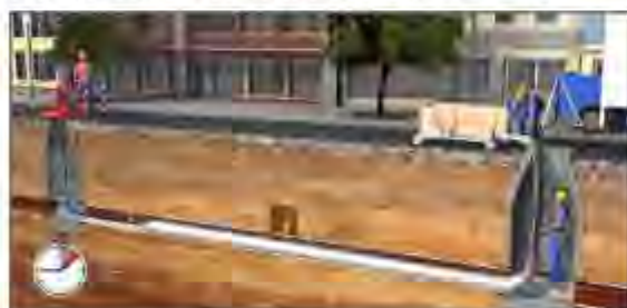
Figura 14: Reparació amb mànega d'un col·lector
