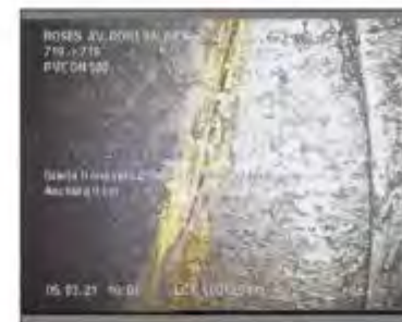
Figura 48: Fissura longitudinal entre els pous de registre 719 - 715
