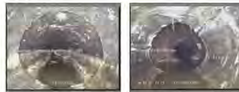
Figura 17: Erosió de la solera i canvi de diàmetre del col·lector entre pous de registre 844 – 816. Aixafament del col·lector entre els pous 816 – 818.
