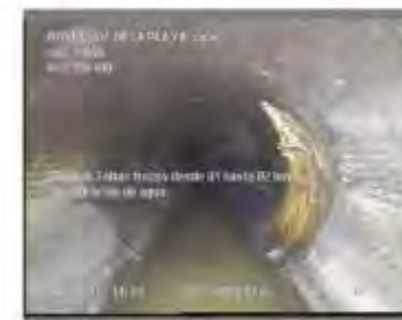
Figura 30: Erosió de la solera entre pous de registre 662 – 660
