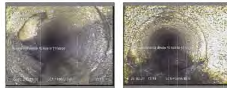
Figura 43: Col·lector amb filtracions a les seves juntes i espaiament, entre pous de registre 803 – 804. Col·lector amb filtracions a les seves juntes i avançant estat de deteriorament.
