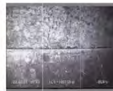
Figura 52: Fissura longitudinal entre els pous de registre 640 - 639
