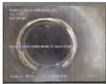
Figura 46: Fissura longitudinal entre els pous de registre 722 - 721
