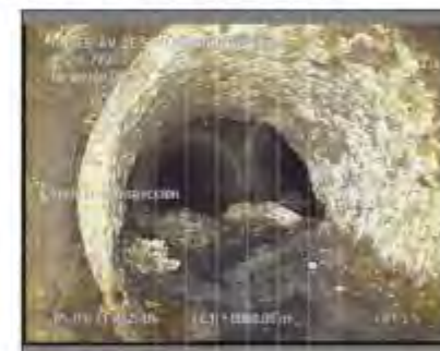
Figura 25: Fallada estructural del col·lector entre pous de registre 773 – 712
