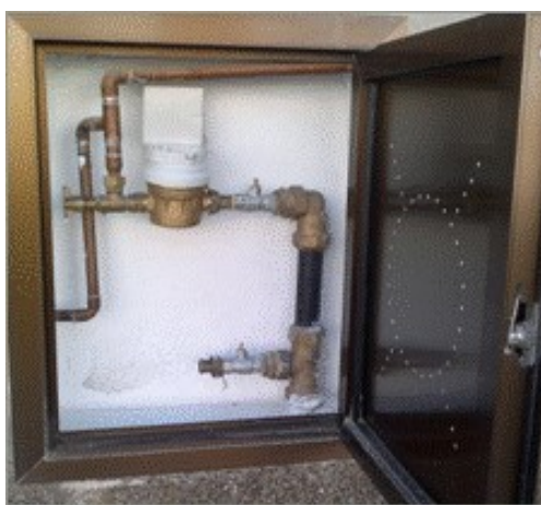
Exemples d'instal·lacions de comptador amb mòdul de telemesura incorporat
