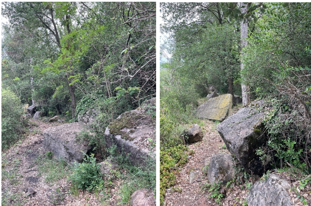
Il·lustració 15. Blocs provinents del desmunt de la carretera i que han de ser trets mitjançant resines o ciments expansius. Corresponen al punt 5 del plànol.
