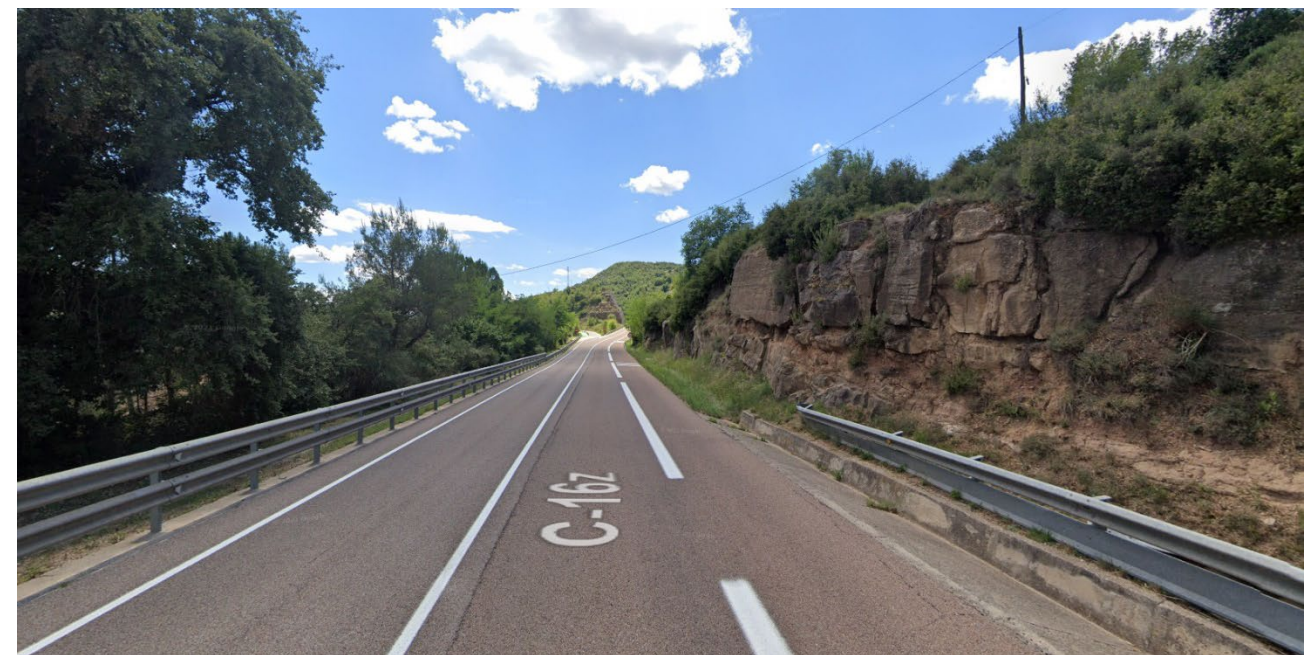
Foto 03: Tram final. Transició de rasa de formigó a rasa verda
