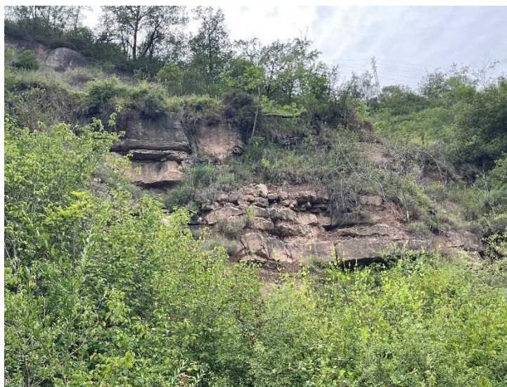
Il·lustració 17. Acumulació de petits blocs a la coronació del talús. Cal sanejament.
