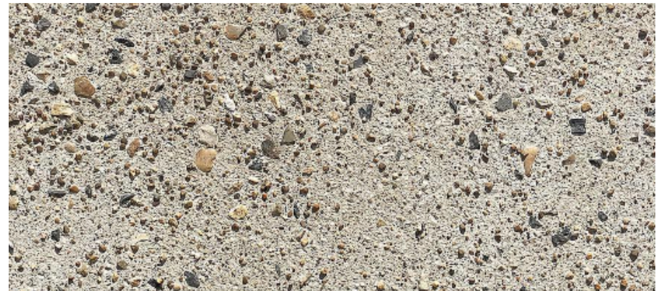
Acabat del paviment de formigó
