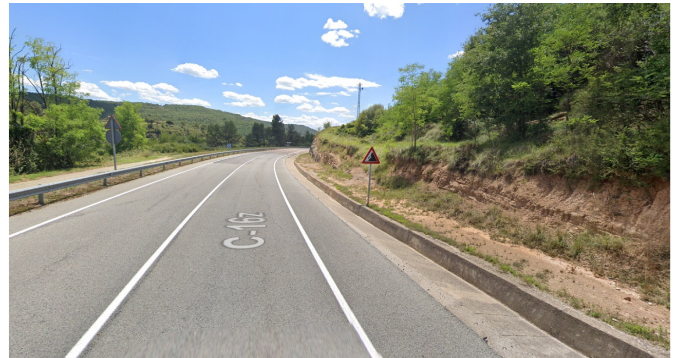
Foto 02: Tram central, amb rasa de formigó per la recollida d'aigua
