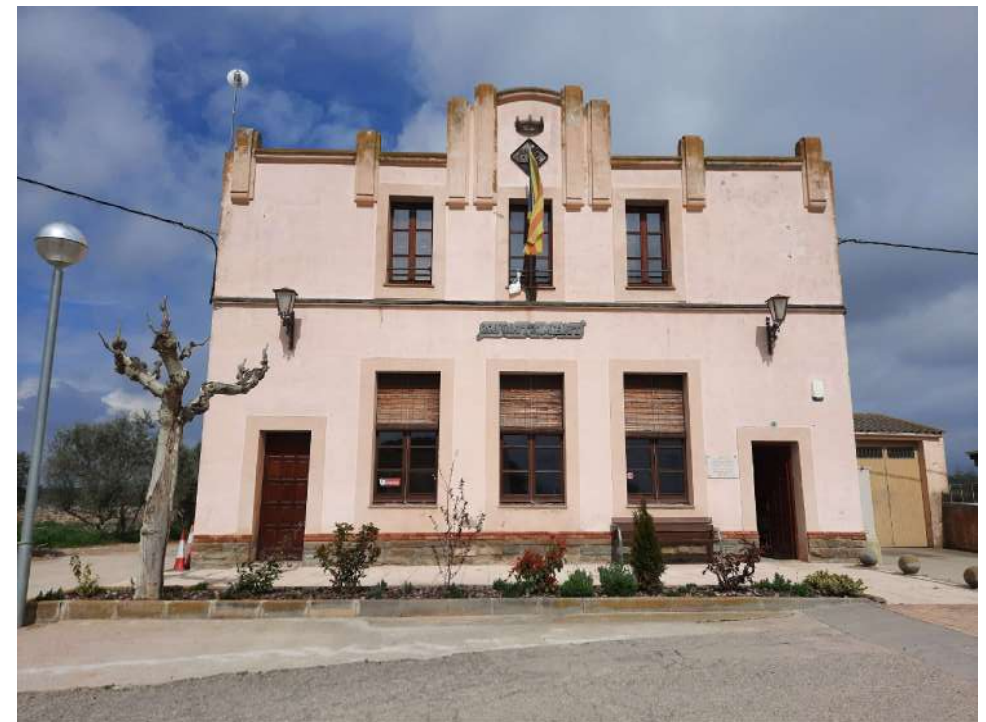
FOTOGRAFIA FAÇANA PRINCIPAL
