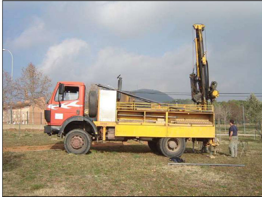
Foto 3: Màquina realitzant un dels sondejos.
