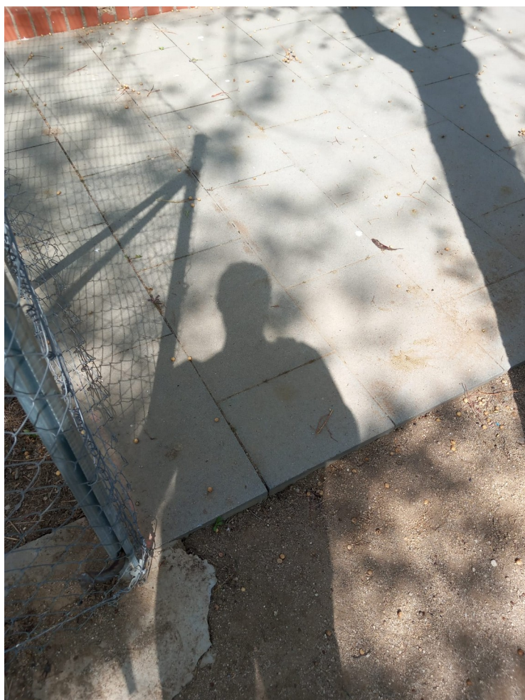
Fotografia 4. Paviment actual peçes formigó 60x40cm
