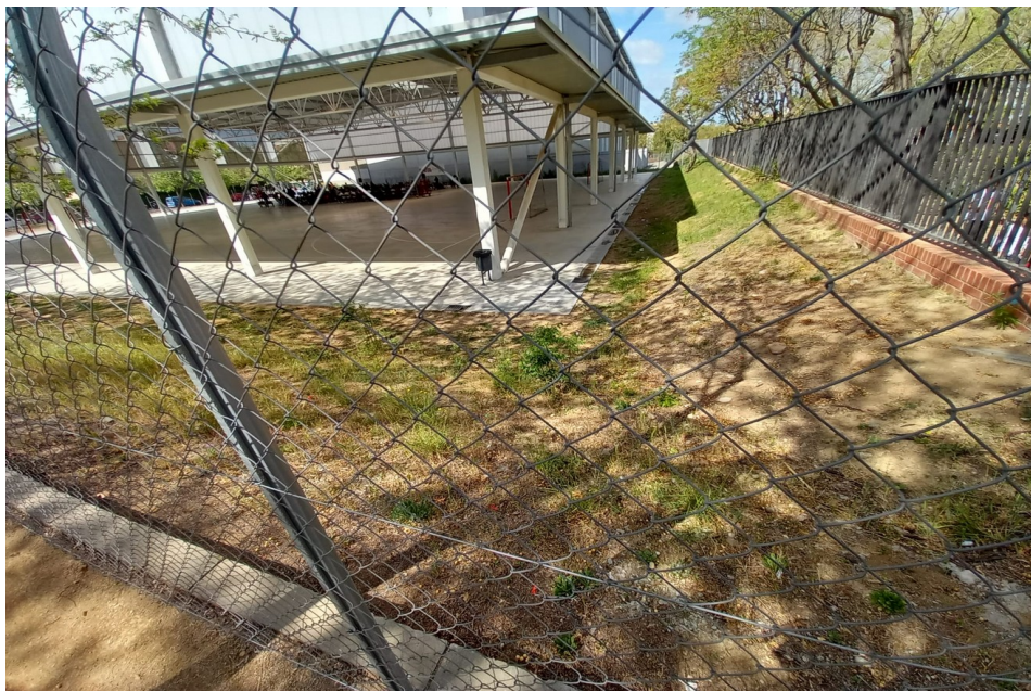
Fotografia 2. Zona escales i inici rampa
