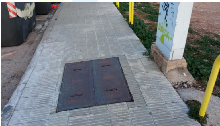
Detall arqueta telefònica Carrer dels Ocells
