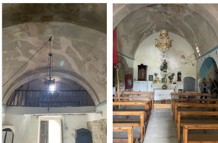
Presència d'humitat a l'interior de l'església
