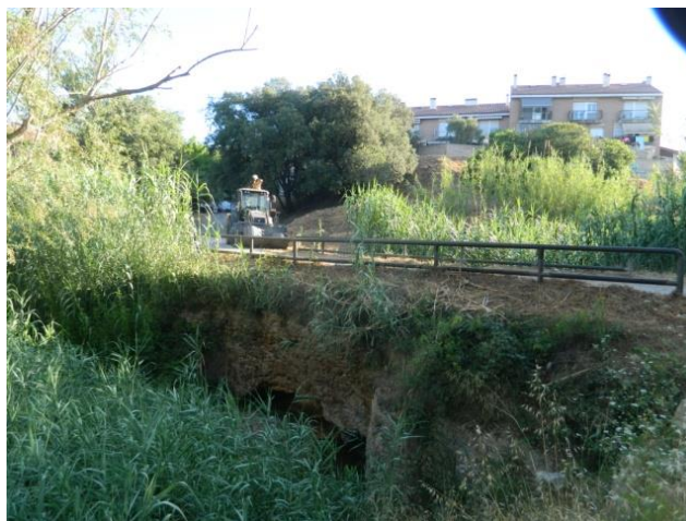
Imatge del pont abans de la intervenció de l'any 2021. Triade
