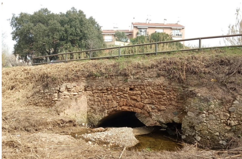
Vista del costat sud-oest del pont. Triade
