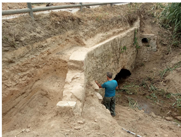
Contraforts del costat est (Cala Ext E). Triade
