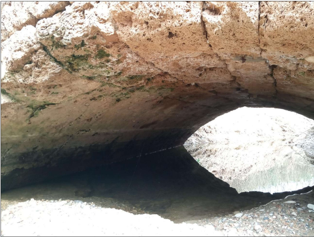
Volta de canó de l'ull del pont des de l'oest
