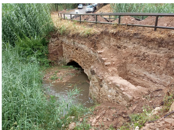
Contraforts del costat oest (Cala Ext W). Triade
