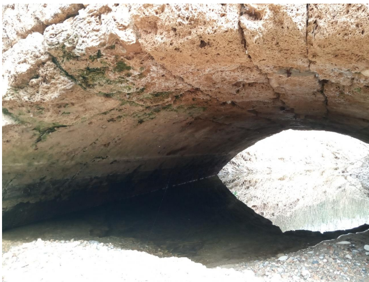
Ull del pont des de l'oest, amb la clàssica volta de canó. Tríade
