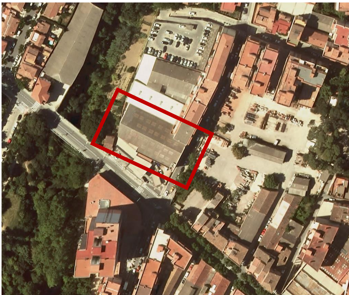
EDIFICI A INTERVENIR I COBERTA A REHABILITAR
