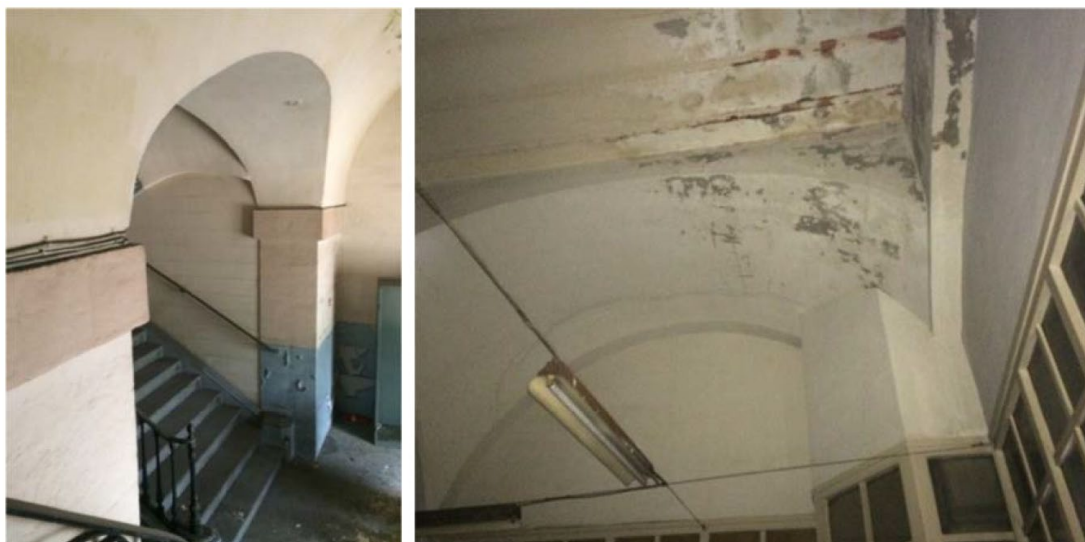
Forjat del terra de planta primera: sistema de voltes i forjats de biguetes metàl·liques
