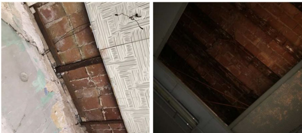
Forjat de biguetes metàl·liques de les plantes superiors.
