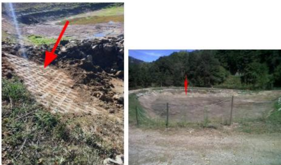
Imatge 8 Instal·lació de les noves gelosies i instal·lació de nous puntals.
