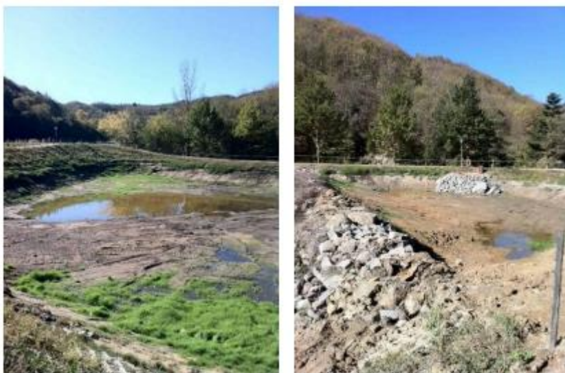
Imatge 10 Acabament de l'actuació, a l'esquerre zona de sedimentació i a la dreta zona d'afinament. Any 2011.
