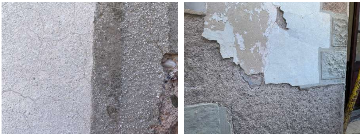
Fotografies detall on s'aprecia el morter M4 com a estucat decoratiu combinant el blanc per la façana i gris per les obertures
