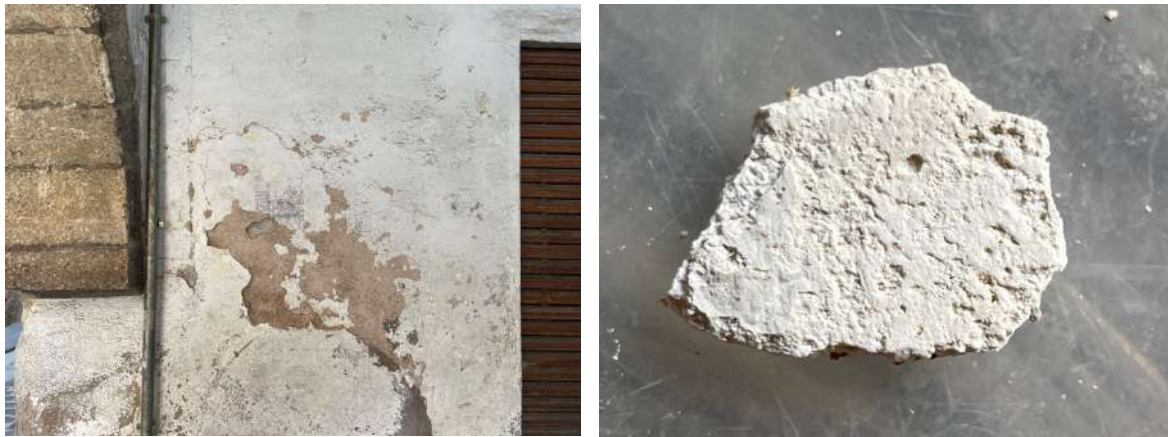
Fotografies detall on s'aprecia el morter M8 aplicat com a lliscat del interior del porxo
