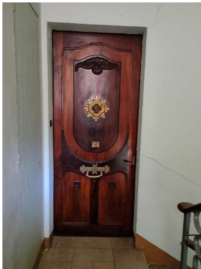
Imatge 6. Porta d'accés al pis principal a conservar.
