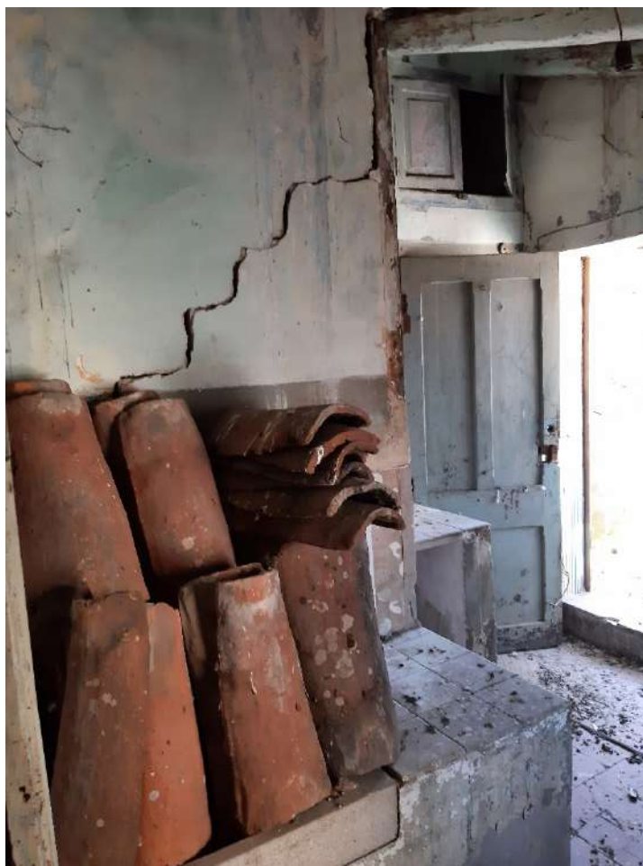
Imatge 12. Interior pis planta sota coberta edifici carrer Major, 4
