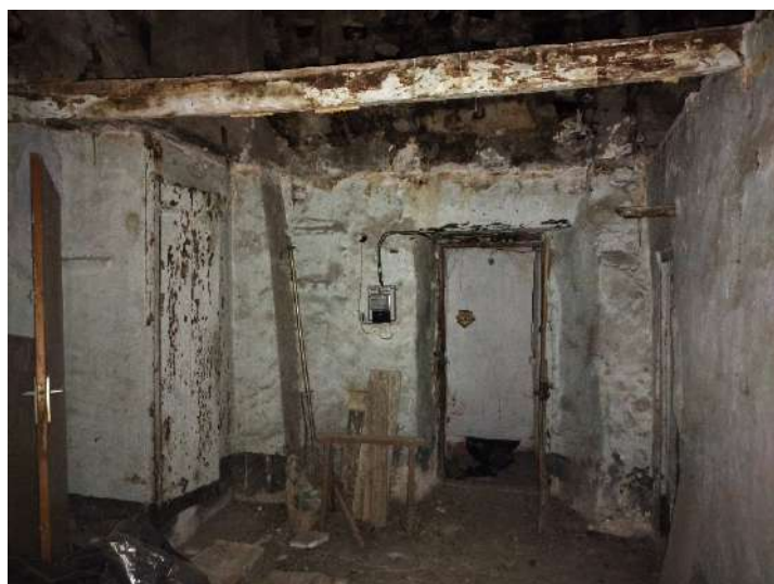
Imatge 13. Interior pis planta sota coberta edifici carrer Major, 4
