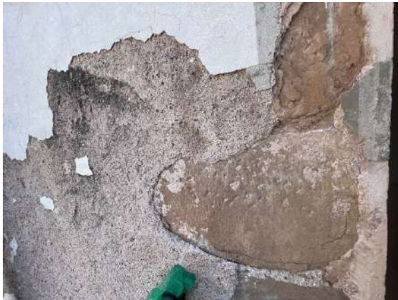
Fotografies detall on s'aprecia el morter M3 aplicat com a capa de farciment o anivellament de totes les façanes
