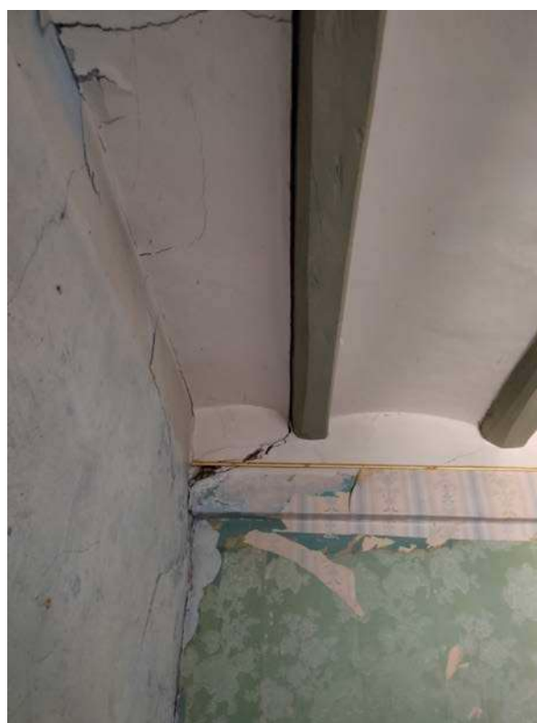
Vista interior Edifici Carrer Major 4 a la planta tercera
