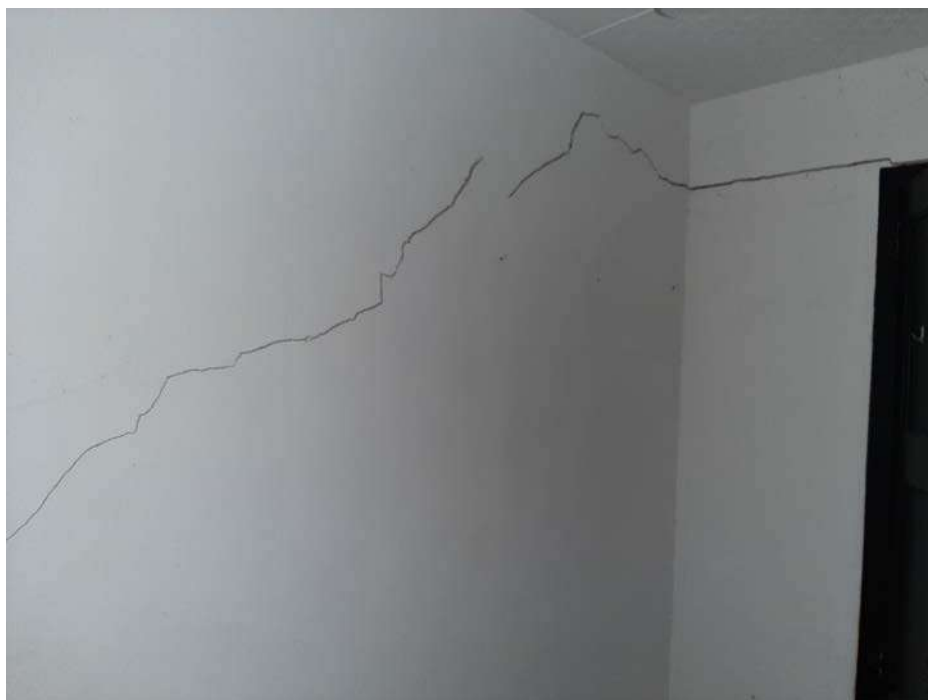
Vista interior Edifici Carrer Major 4 a la planta segona
