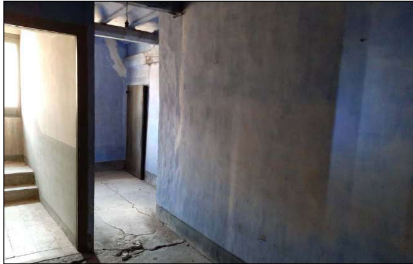
Fig. 45 .Vista d'unes estances de la vivenda, lateral est, de la planta segona de la casa Blanxart.
