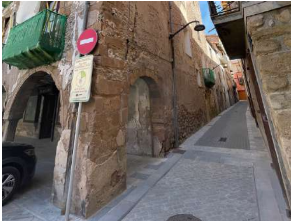
Fotografies detall on s'aprecia el morter M3 aplicada com a lliscat de les façanes laterals
