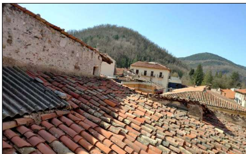
Fig. 49, 50 i 51 . Vistes de dues estances de la planta sotacoberta de la casa Blanxart i de la coberta.
