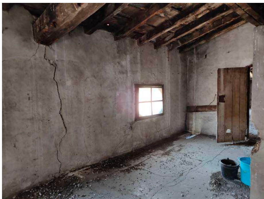
Vista interior de la façana Principal a les golfes
