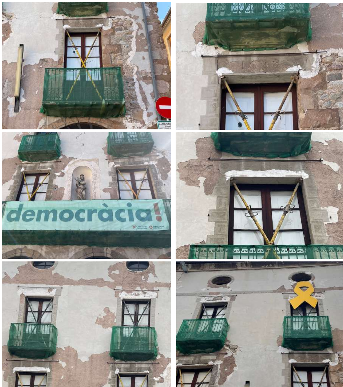
Fotografies detall de l'acabat del emmarcament de les obertures, a la imatge superior dreta s'observa el detall de la data 1648
