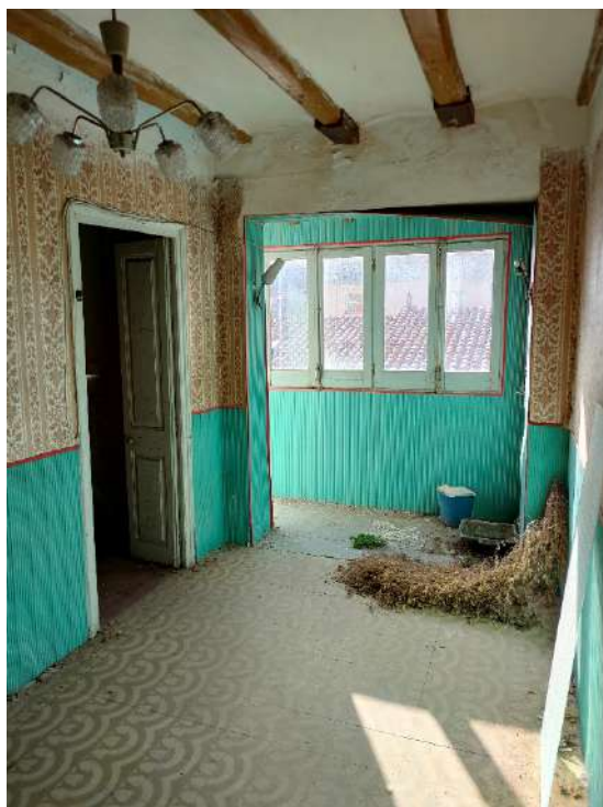
Imatge 10. Interior pis planta tercera edifici carrer Major, 4
