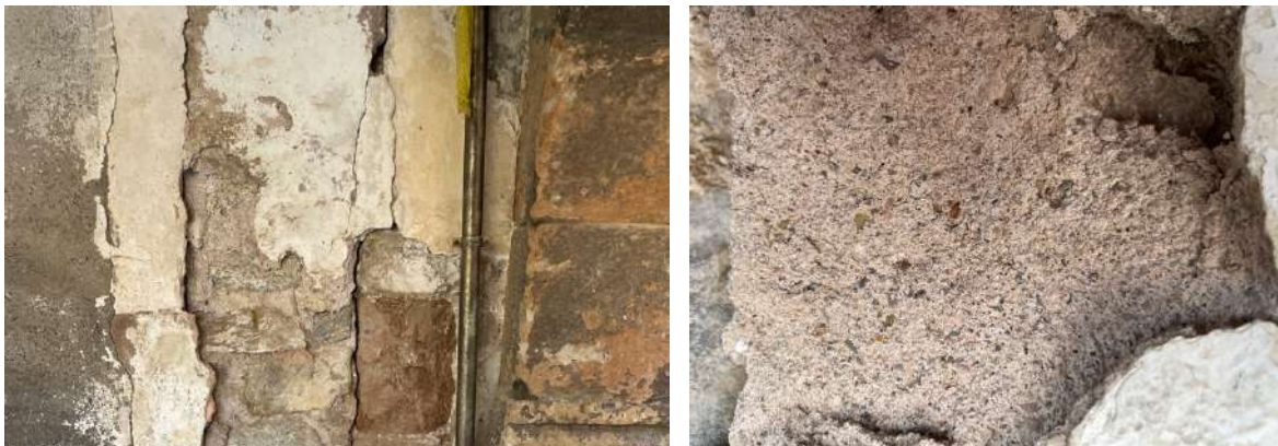
Fotografies detall on s'aprecia el morter M3 aplicat com a capa d'arrebossat del conjunt
