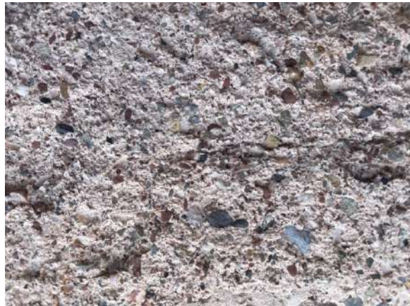
Fotografies detall on s'aprecia el morter M3 aplicat com a capa de farciment o anivellament de totes les façanes
