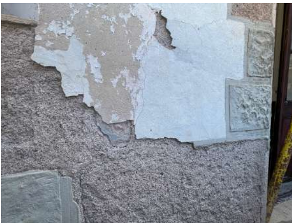
Fotografies detall on s'aprecia el morter M6 aplicat com a morter de farciment d'un orifici
