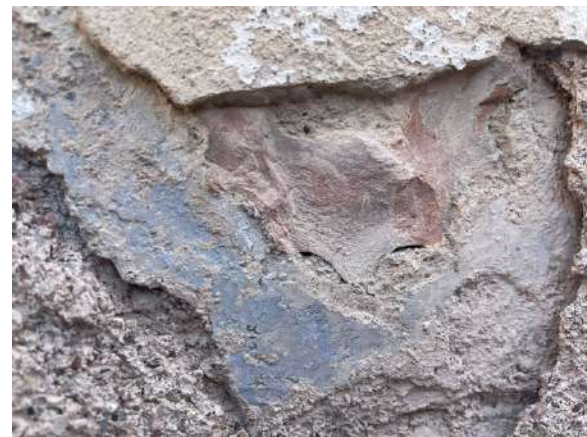
Fotografies detall on s'aprecia el morter M6 aplicat com a morter de farciment d'un orifici
