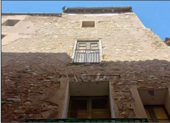
Fig. 10 i 11. Vista dels pisos superiors de la façana oest (esquerra) i est (dreta) de la casa Blanxart.
