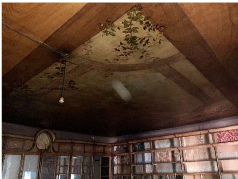
Imatge 5. Sostre interior local de planta baixa a Can Blanxart per conservar.
