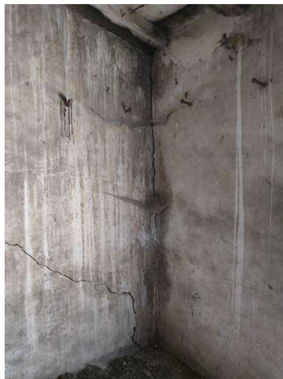
Vista interior de la Façana Principal a les golfes
