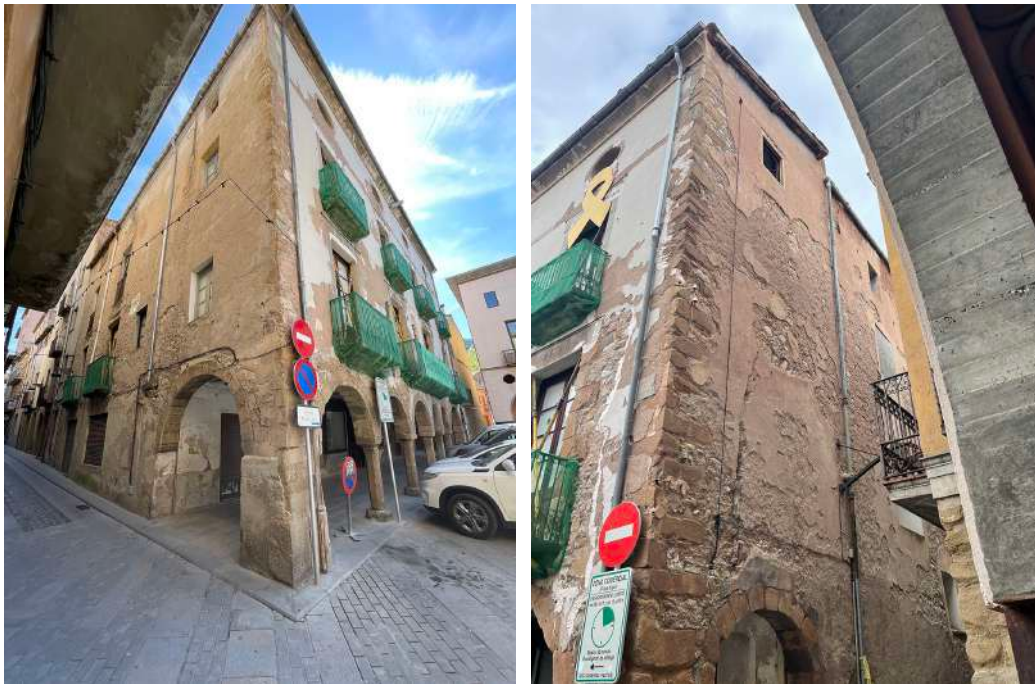
Fotografies de les façanes laterals de Can Blanxart
