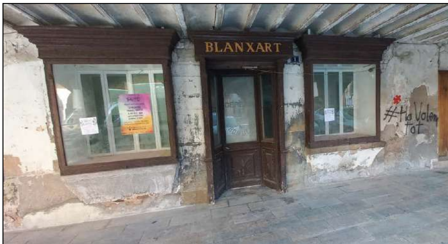
Fig. 18. Vista de l'accés a la botiga que es troba a sota del porxos de la façana principal. Despunten la porta amb el rètol i els aparadors laterals.
