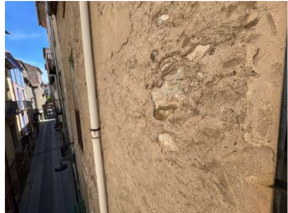
Fotografies detall on s'aprecia el morter M3 aplicada com a lliscat de les façanes laterals
