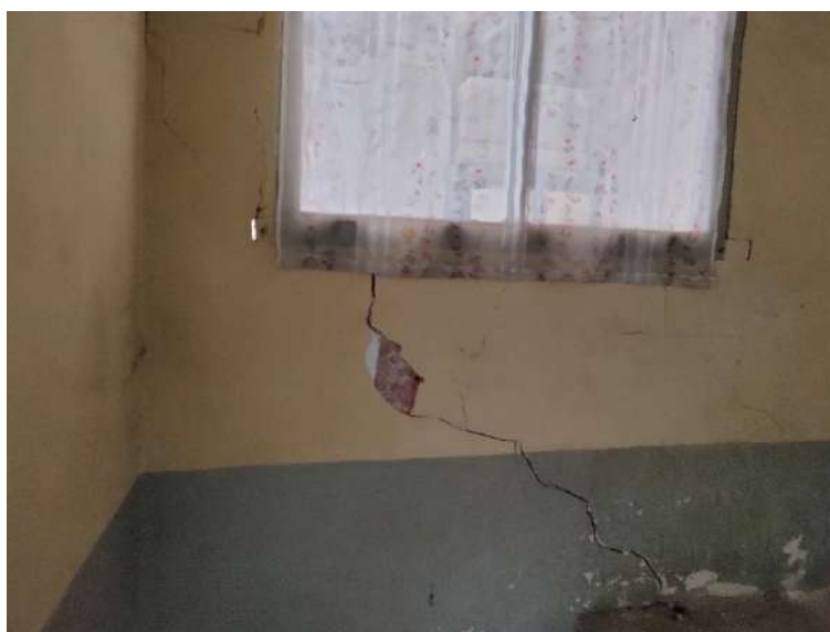
Imatge 11. Interior pis planta tercera edifici carrer Major, 4
