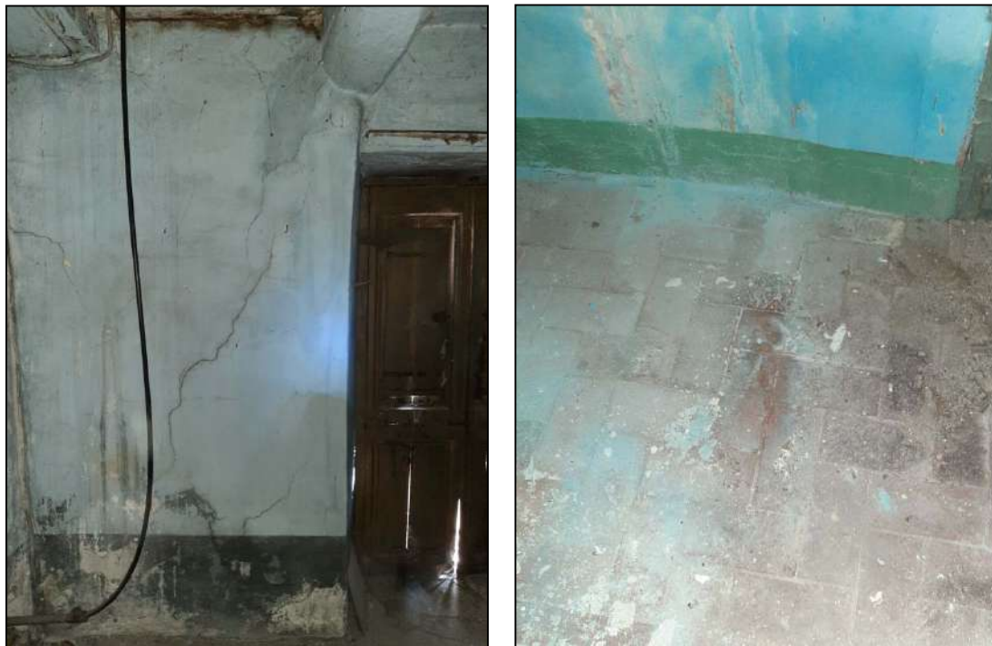
Fig. 47 i 48 . Vista d'una estança de la vivenda, lateral oest, de la planta segona de la casa Blanxart i detall del paviment amb tova manual que hi ha a tota la planta.
