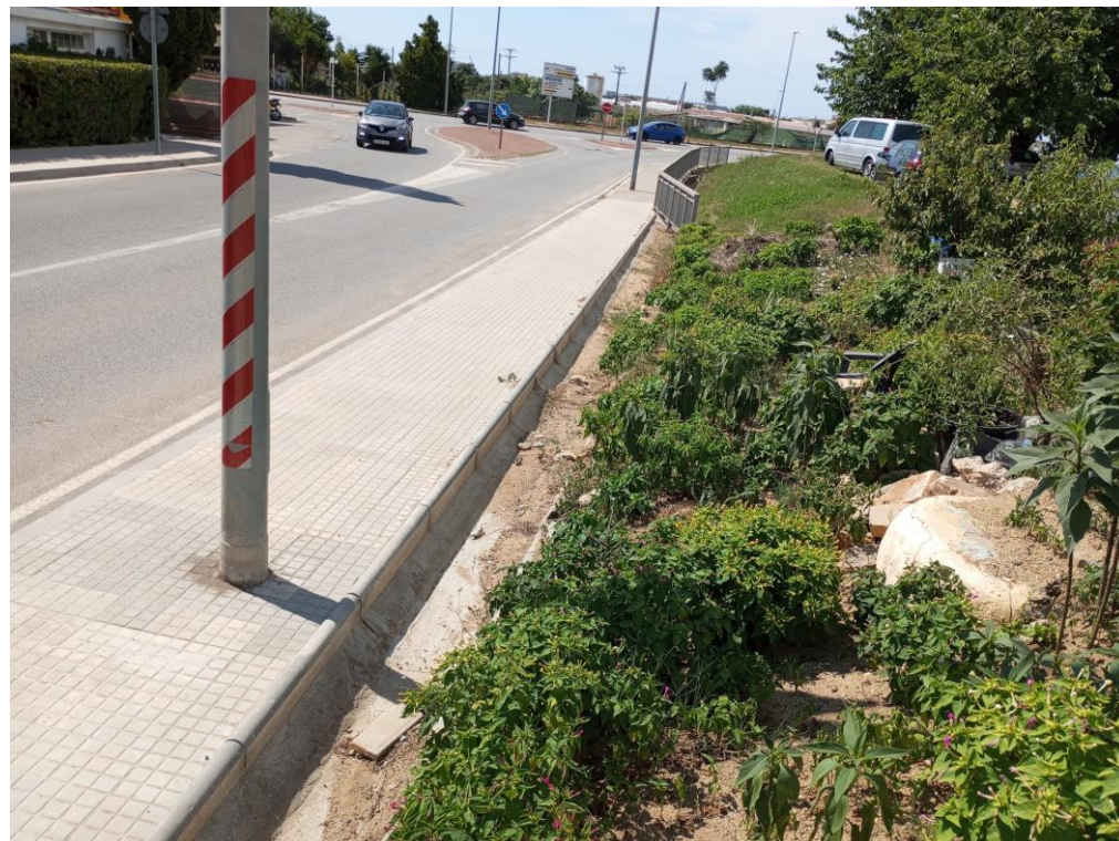
Fotografia 6. Unió entre l'aparcament i la BV-6002.
