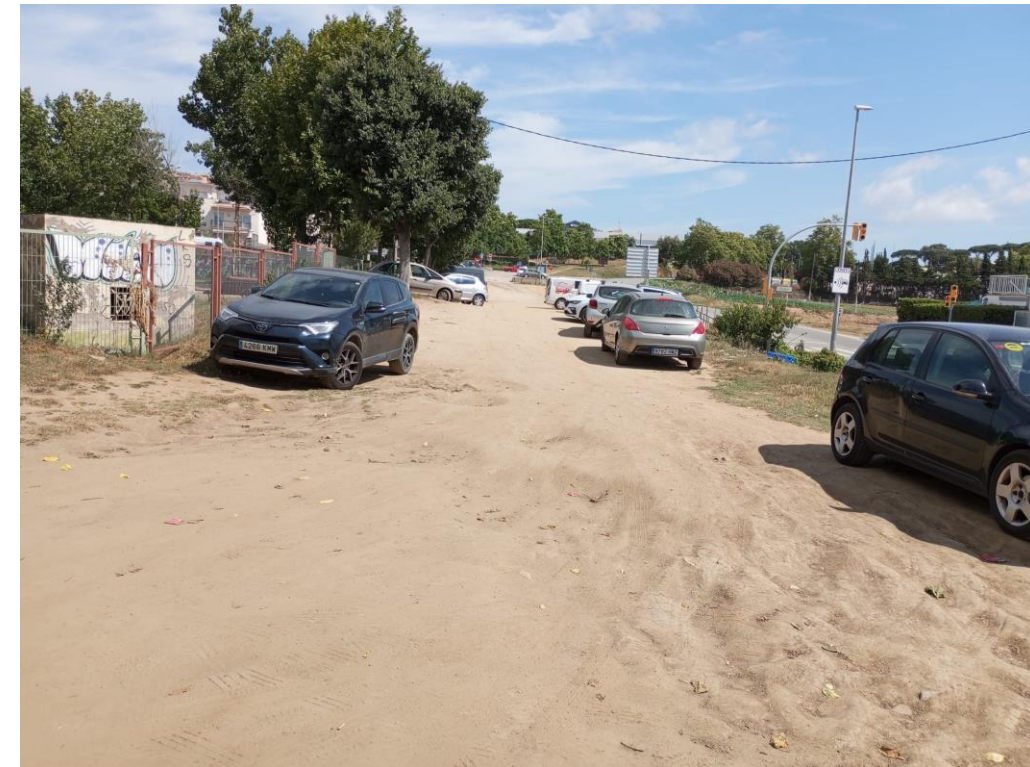
Fotografia 3. Part central de l'aparcament que es troba en mal estat
