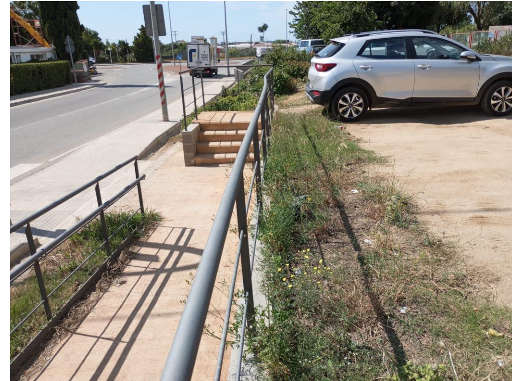
Fotografia 7. Accés a l'aparcament de la vorera de la BV-6002
