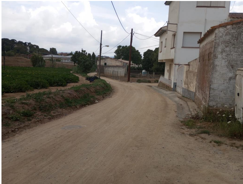
Fotografia 6. Cuneta de formigó i tapa de clavegueram a l'eix del camí.
