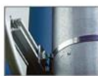
Conjunt de senyal col·locada a fanal amb fleix, tanca i abraçadora.
