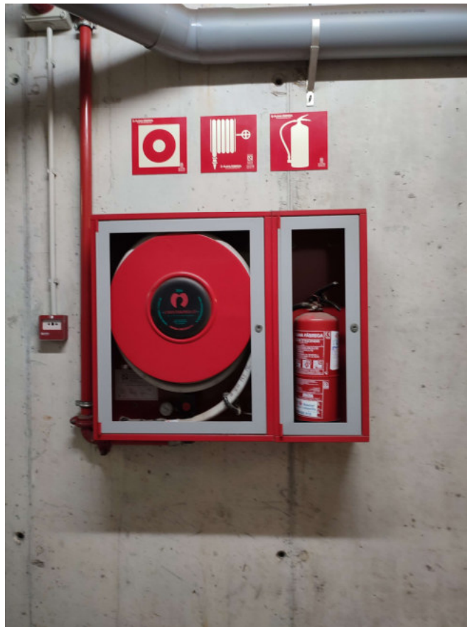
Planta soterrani. Passadís instal·lacions. Falta el vidre
