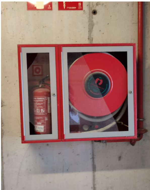
Planta soterrani. Sota piscina. La foto de l'esquerra es veu la Ble amb el vidre trencat, i la foto de la dreta, l'extintor no te vidre
