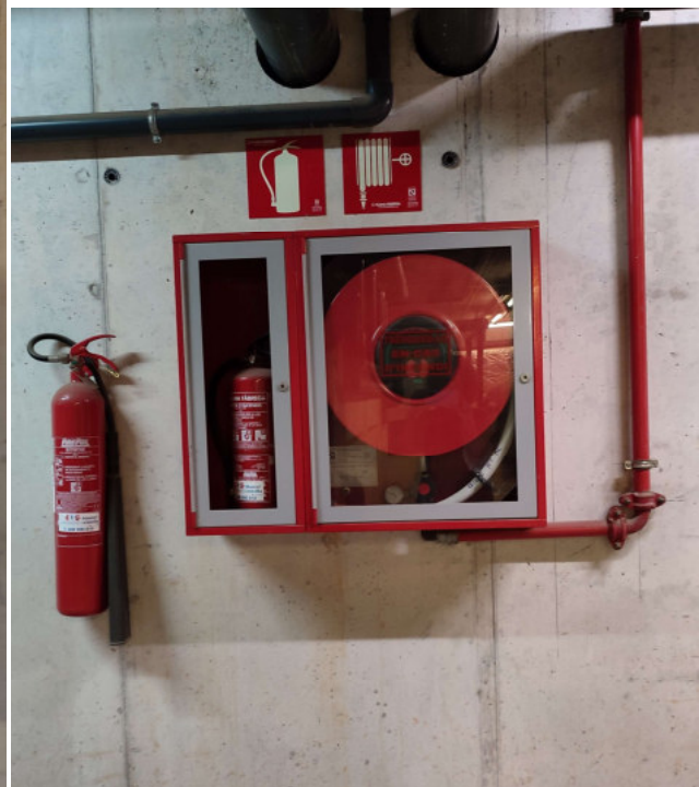
Planta soterrani. Sota piscina. La foto de l'esquerra es veu la Ble amb el vidre trencat, i la foto de la dreta, l'extintor no te vidre
