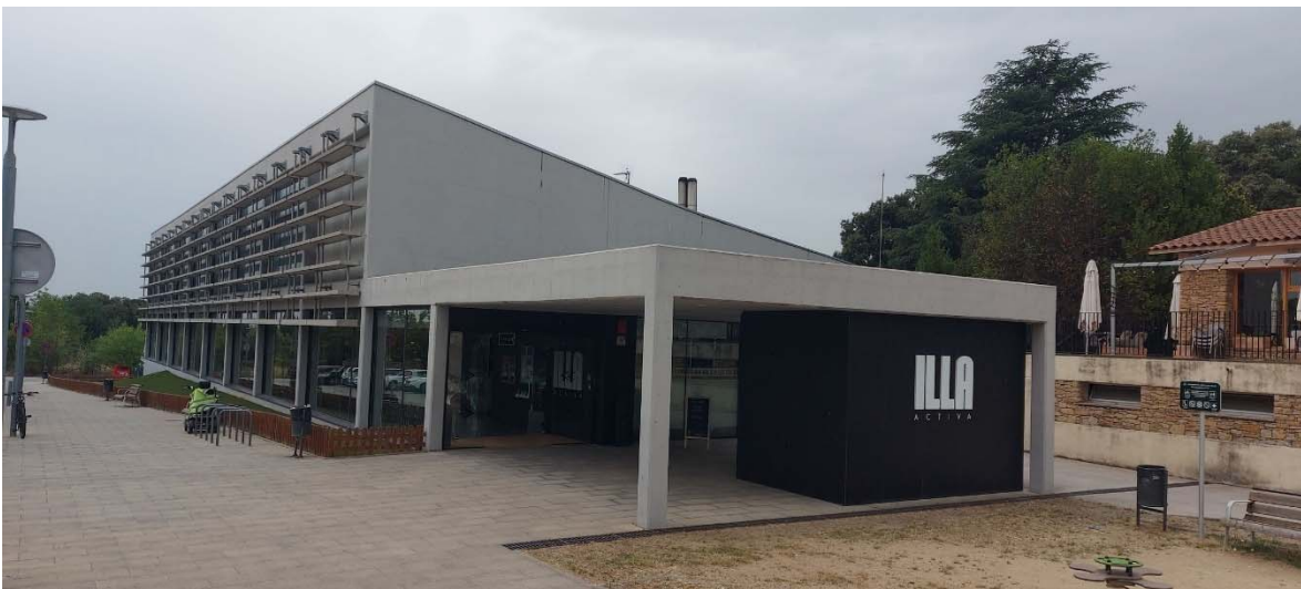
Façana Nord - Accés
