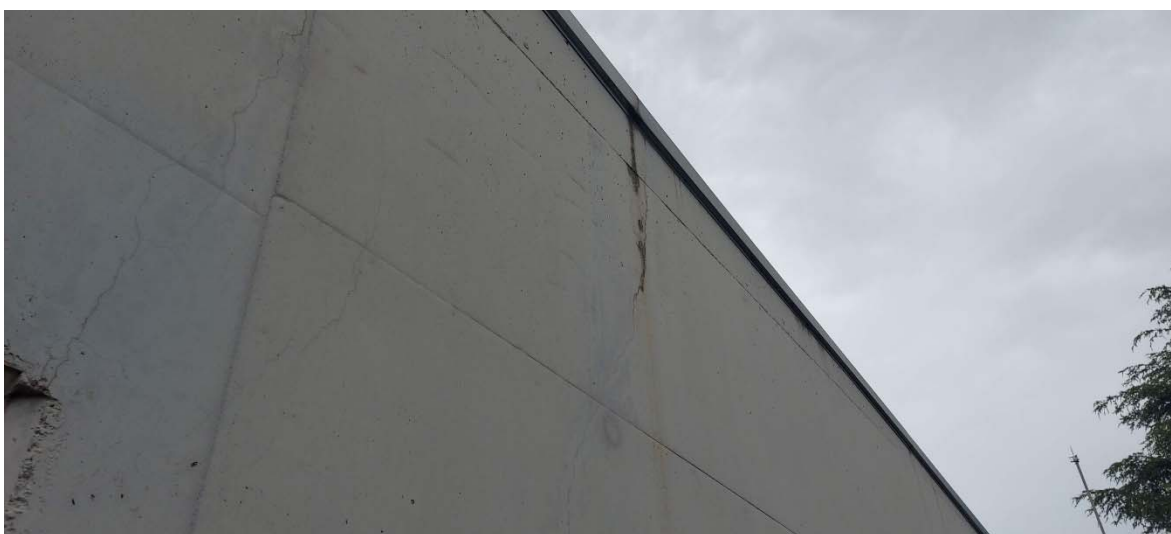
Coberta plana sala instal·lacions
