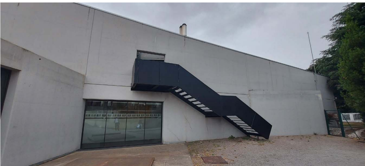
Façana Nord – Accés Coberta Instal·lacions
