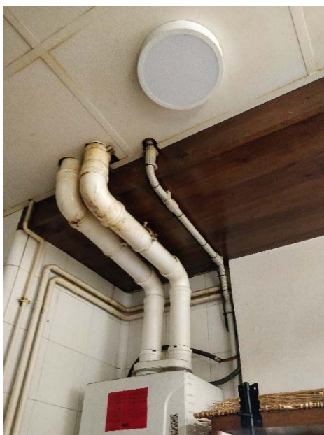
Vista tubs de sortida de fums campana extractora i caldera de gas
