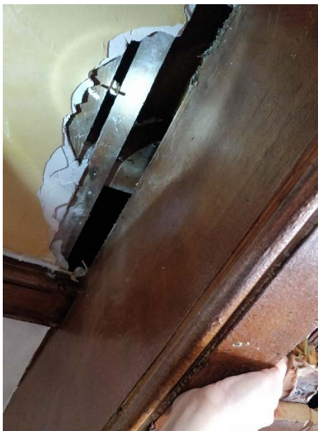
Fals sostre de guix sota bigues secundàries
