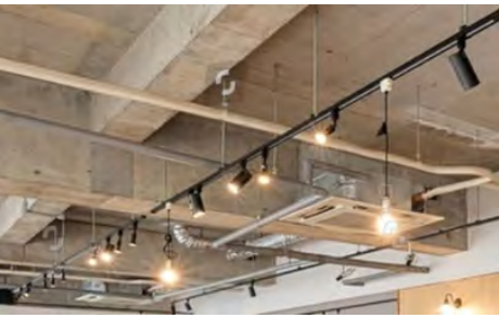
Carril electrificat sobre barra amb focus i làmpades penjants
