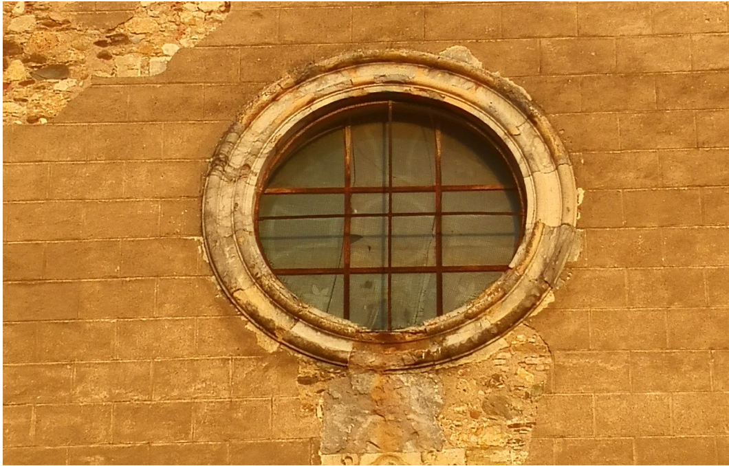
Visió general de la rosassa abans de la intervenció
