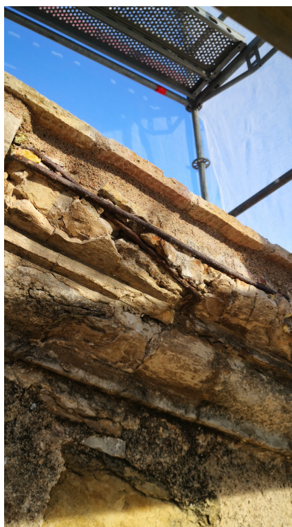
Tram de cornisa amb ciment i ferro
