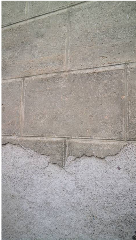
Detalls del material petri de la façana.
