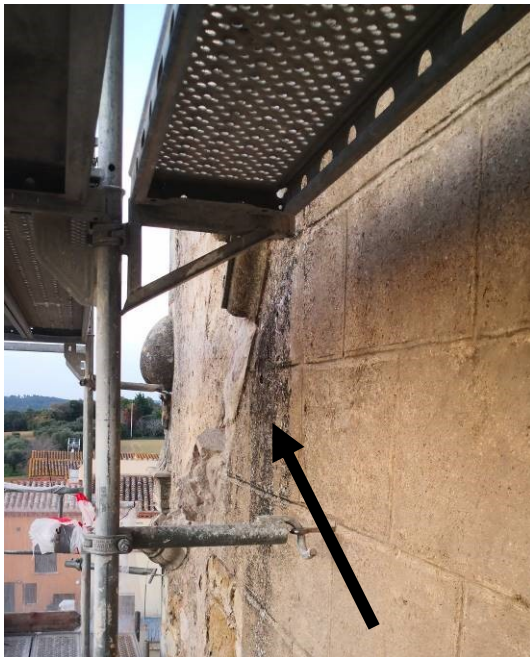
Eliminació de crosta negra en parament de façana
