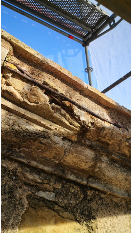
Detall elements ceràmics consolidats
