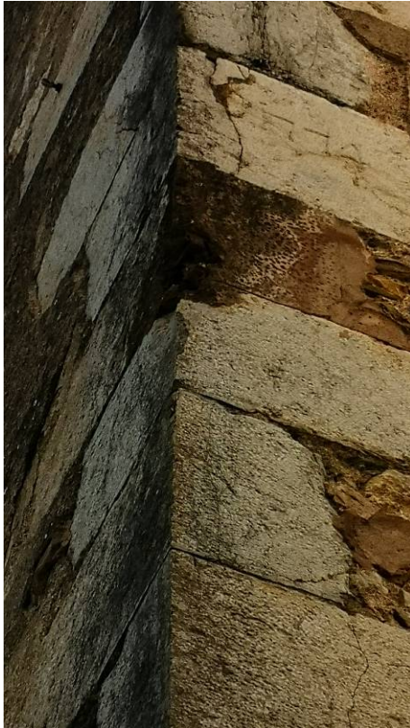
Detalls de l'estat de la pedra de les cantonades
