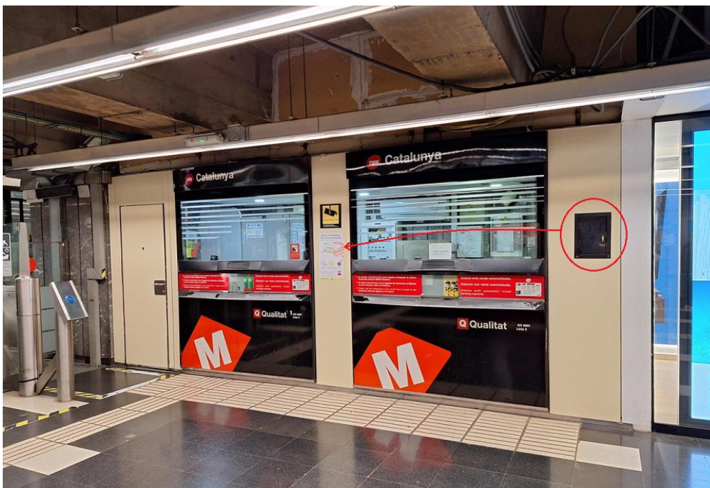
Figura 2 Desplaçament caixa telefònica a Catalunya L3
