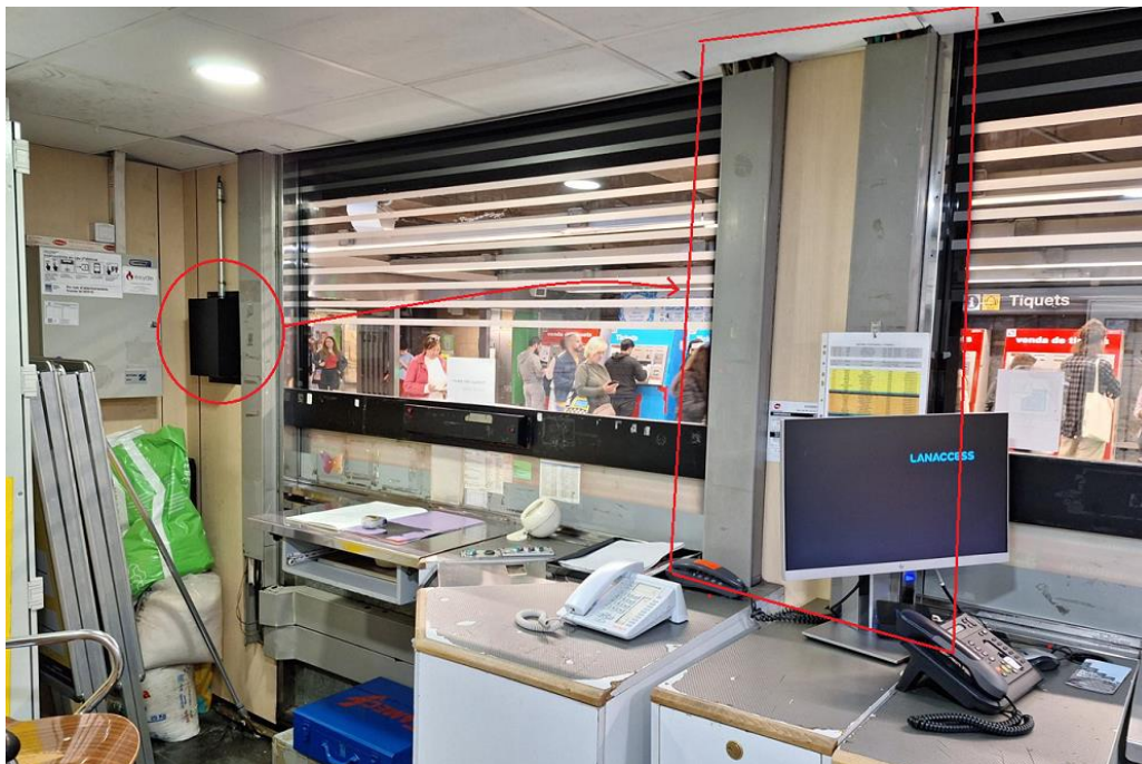
Figura 4 Vista dels elements afectats de la cabina de Catalunya L3
