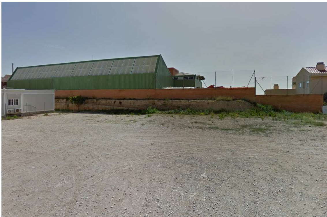
Façana posterior (parcial) – Carrer de Camarles
