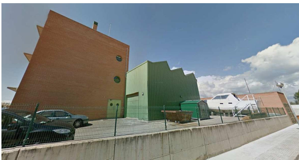
Façana lateral est – carrer de l'Hort d'Albacar
