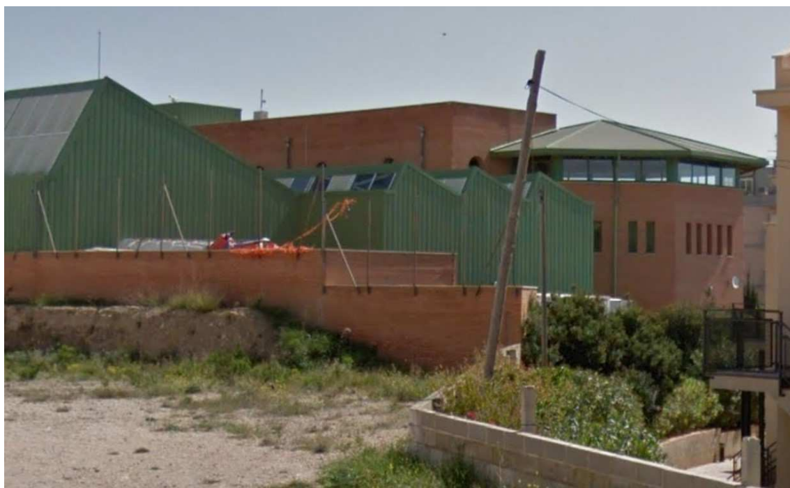
Façana lateral oest (parcial)
