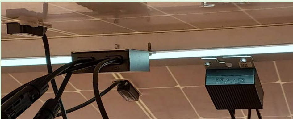
Marc foradat quan el optimitzador té el forat indicat per ser instal·lats en els forats del panell. No confondre els forats del terra amb els forats habilitats per altres utilitzacions com per exemple, acolliments per sota.
