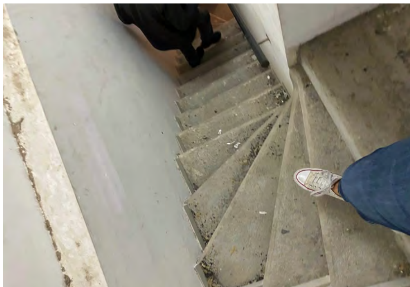
Accés a coberta
