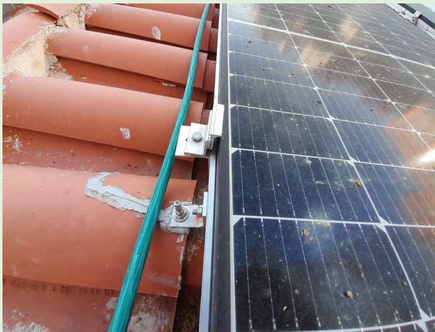
Exemple d'una grapa mal col·locada on no s'abraça perfectament el marc del mòdul.
