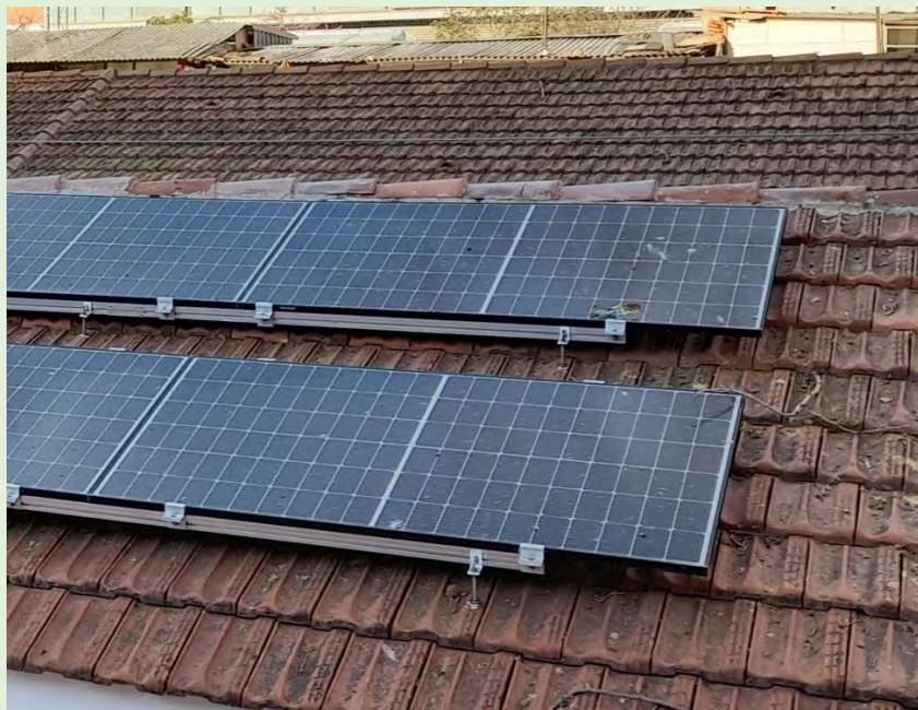
Mòduls en voladiu sense cap àrea de recolzament.
