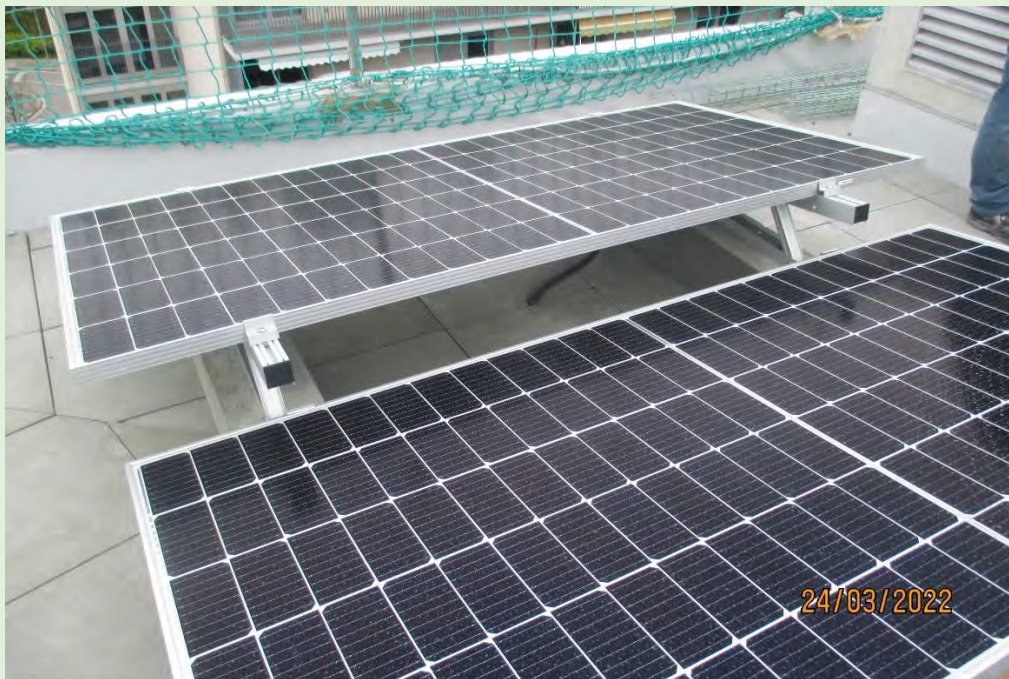
Foto d'exemple d'una IESFV amb estructura de triangle on no es deixa espai per evitar ombres.
