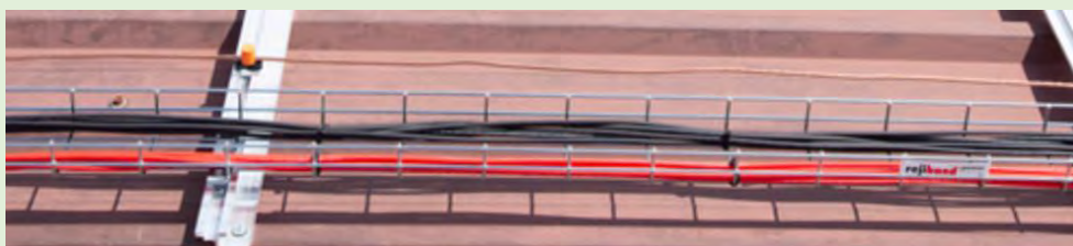
Exemple de cablejat CC positius per una banda i negatius per un altre ben pentinats.
