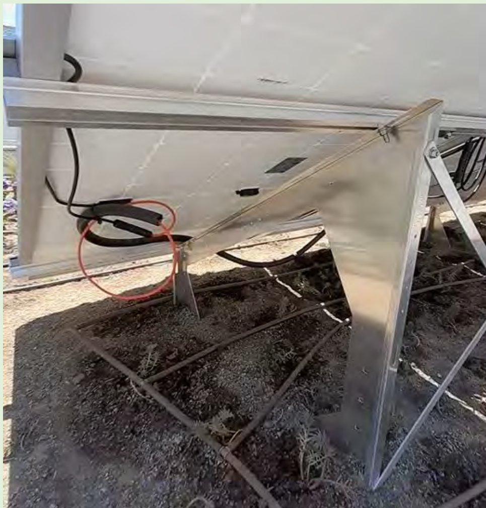
Foto on es detecta un voladiu important que amb molt poca força pots moure el mòdul.
