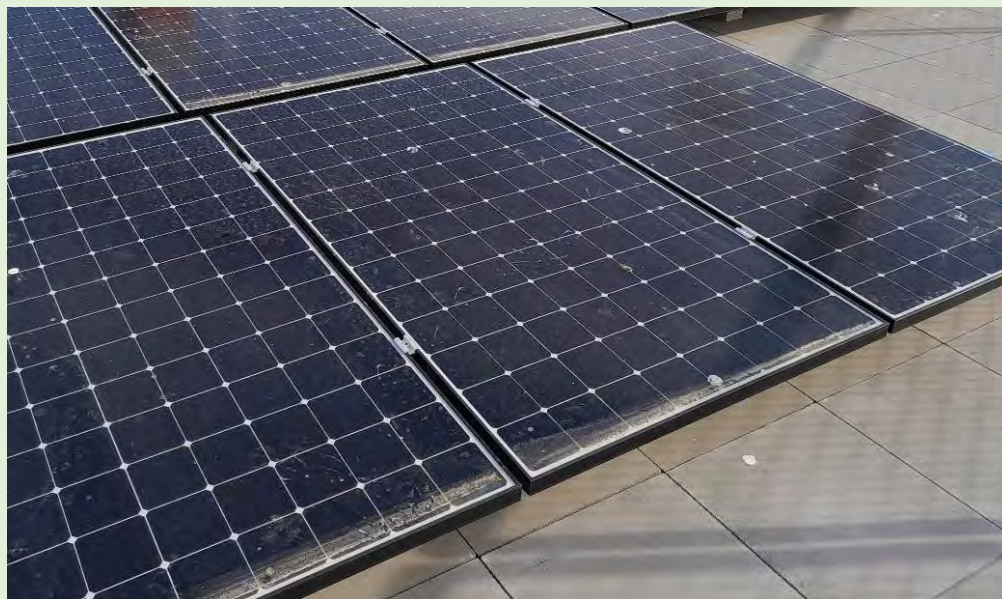
Brutícia acumulada en un ambient de pols per petita inclinació del mòduls.
