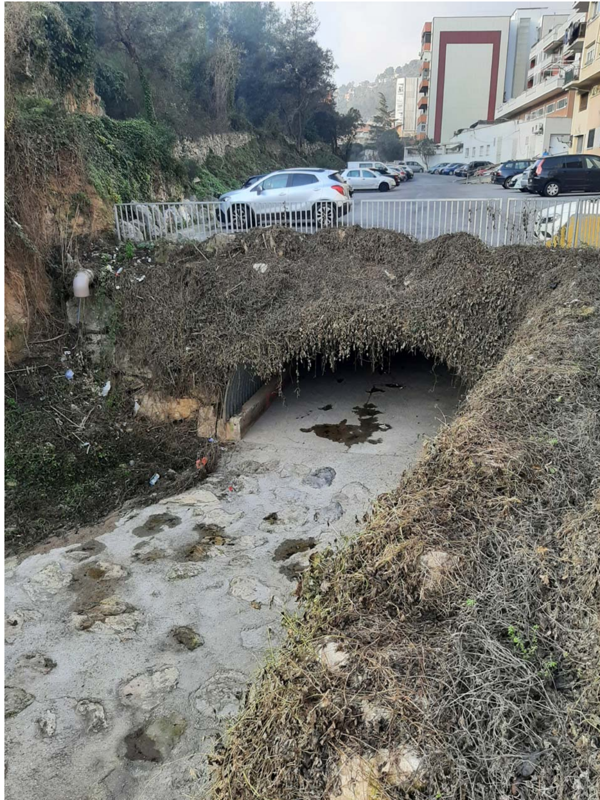
1. Sortida de la canalització existent sota l'aparcament del carrer Vinyes
