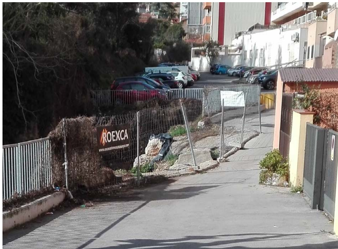
12. Vista del carrer Vinyes, zona de restauració del nivell de la rasant, del paviment i de la vorada i barana de protecció del carrer)
