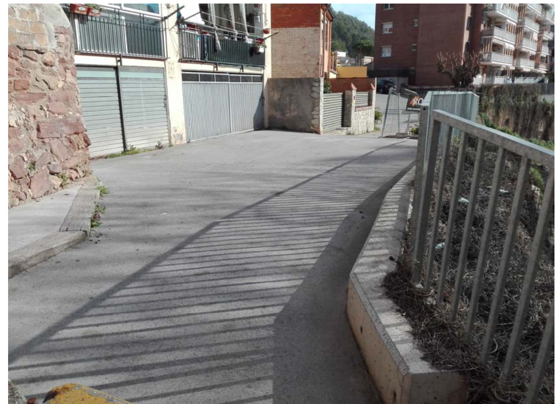
10. Vista general del carrer Vinyes, zona darrera edifici carrer Major número 157 (paviment a substituir)
