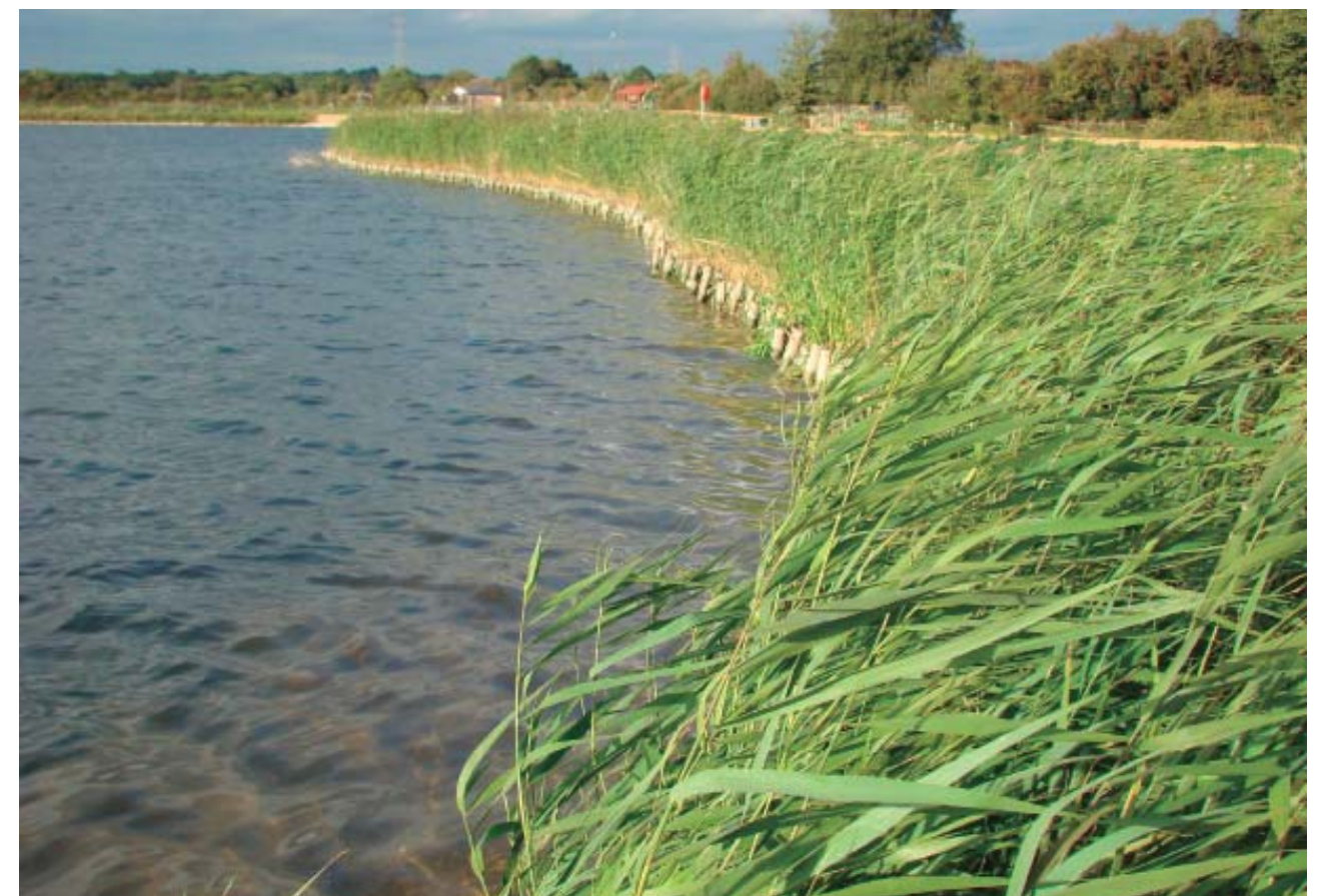
Gabions Rock Roll instal·lats per a protegir els Fiber Rolls (biorrotlles).
