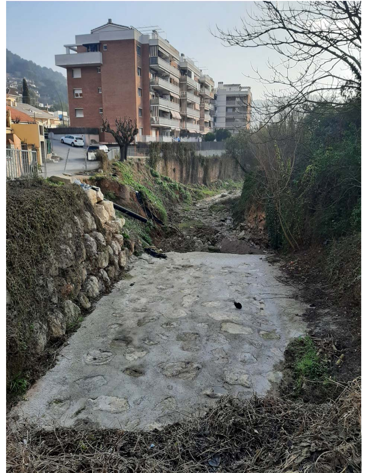
2. Sortida de la canalització existent, vista general de la rocalla formigonada existent a substituir
