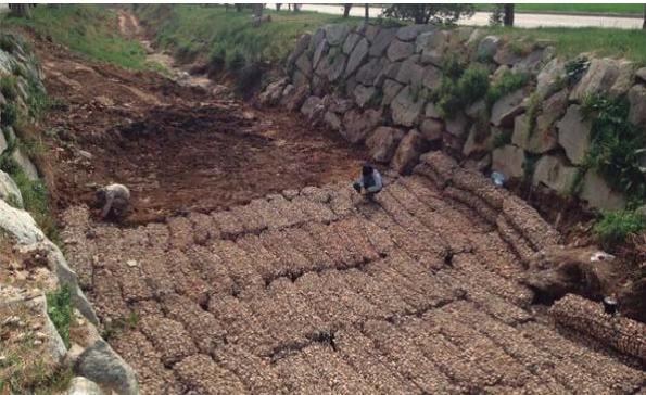
Instal·lació d'un llit de gabions en un tram de transició de canal a llera natural
