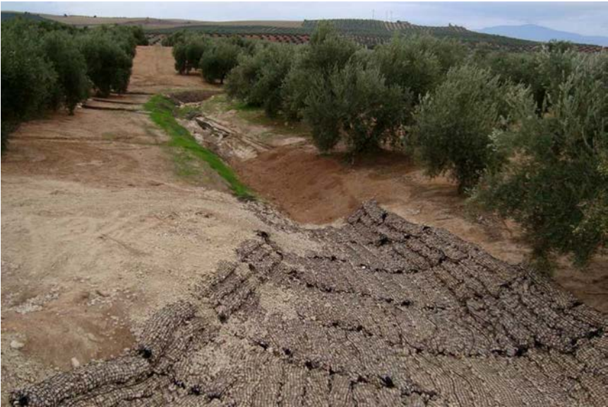
Figura 4. Exemple d'aplicació de gabions per a l'estabilització d'una llera
