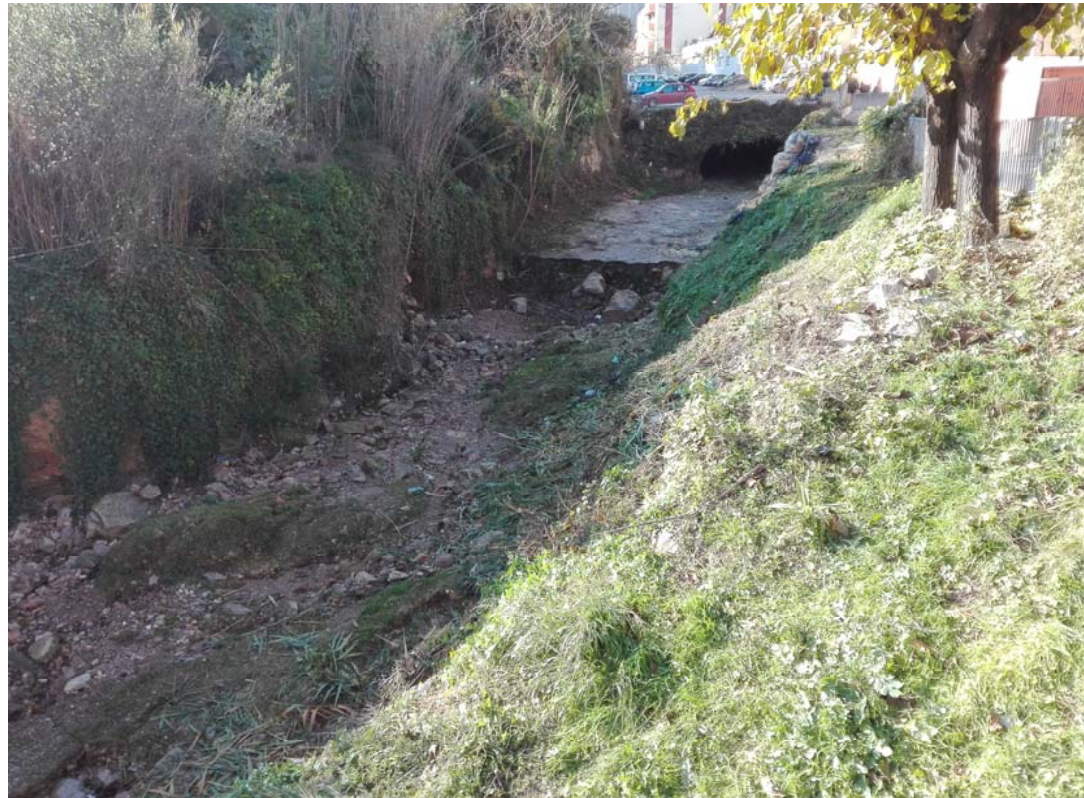
7. Vista superior de la zona de la llera per a la col·locació de gabions tubulars a la llera
