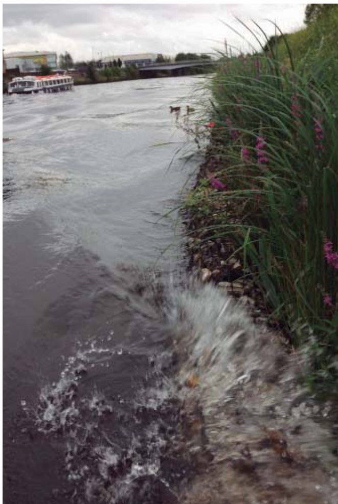
Gabions Rock Roll dissipant l'energia de l'ona al pas d'un vaixell.
