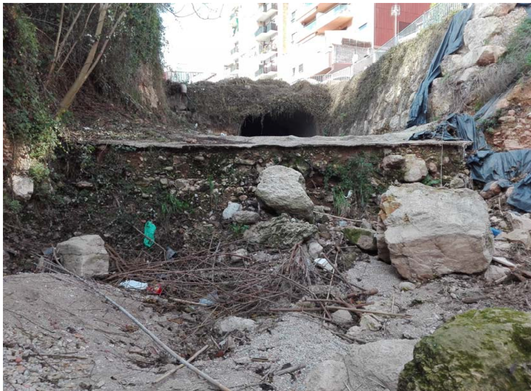
4. Vista detall del final del tramo de rocalla existent de la llera
