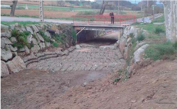
Instal·lació d'un llit de gabions en un tram de transició de canal a llera natural
