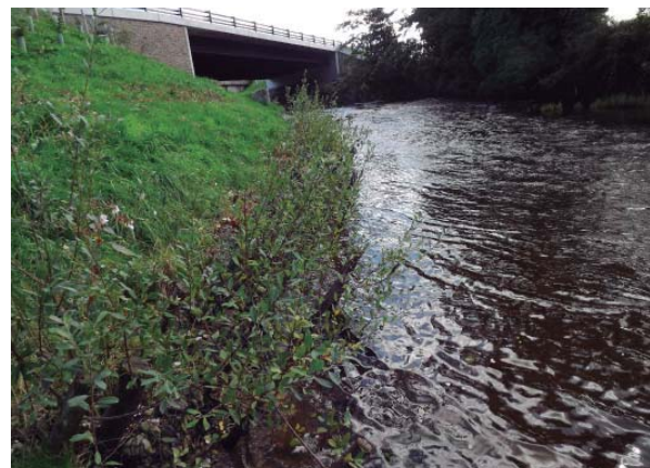
Combinació de gabions Rock Roll i plantació de salzes.
