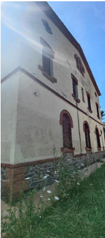
Façana lateral Est:
