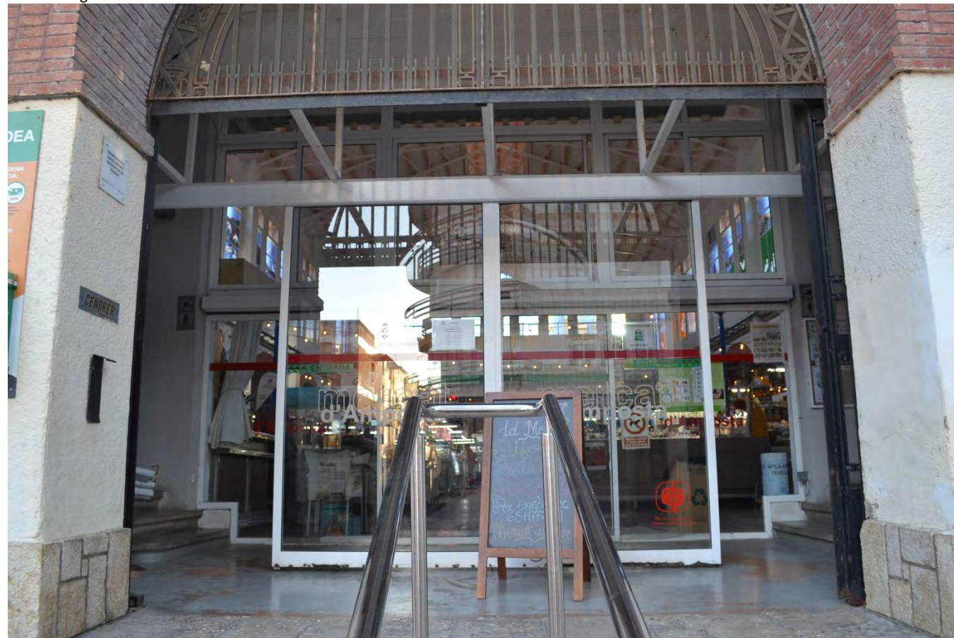
Accés avinguda Alcalde Palau. Mampara mòbil per evitar entrada directa d'aire a l'interior de l'espai de mercat.
