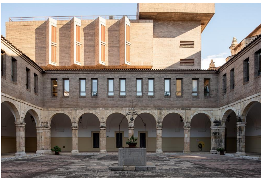
Imatge 2. Fotografia del claustre, amb l'edifici dipòsit al fons.
