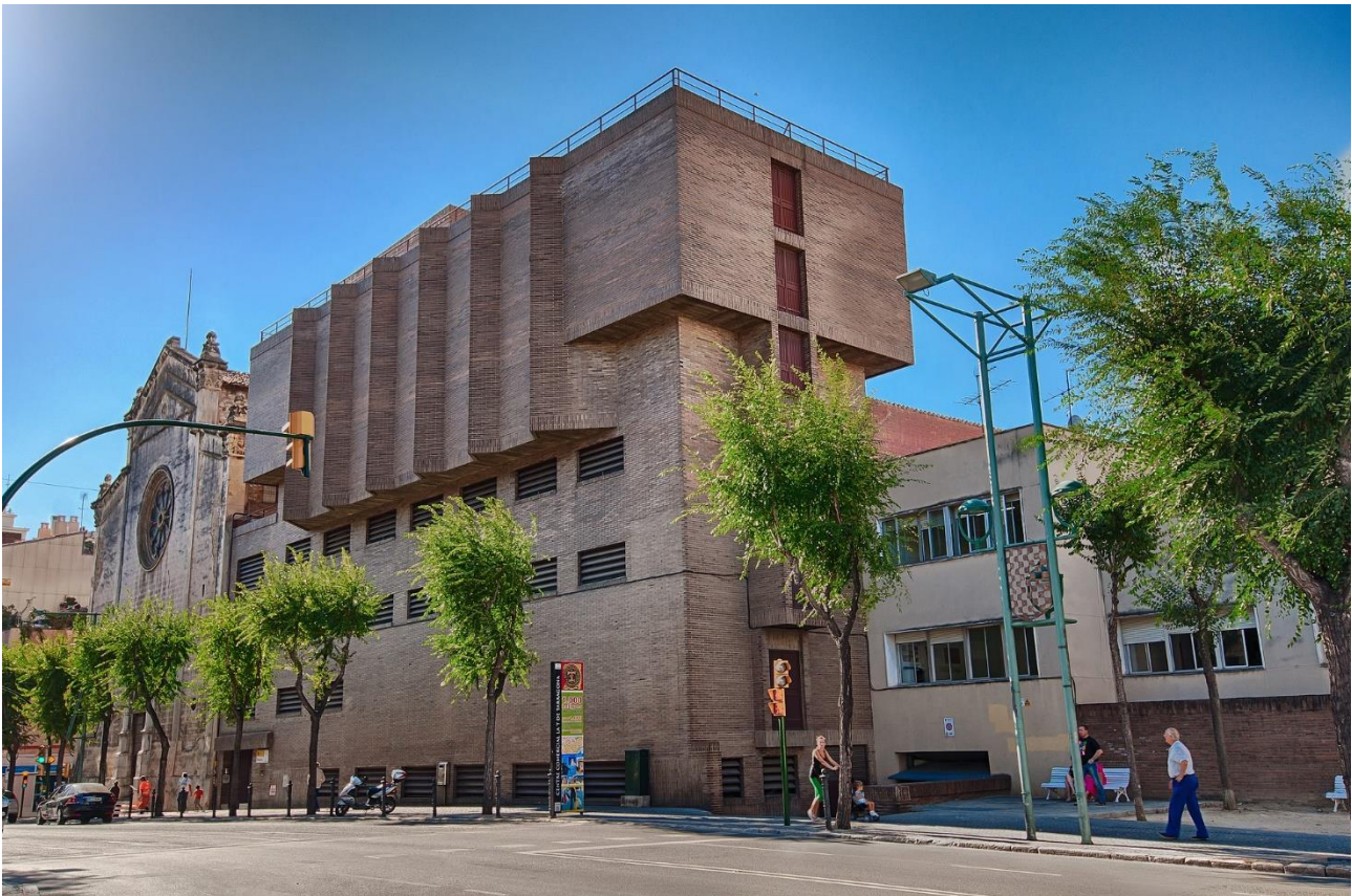
Imatge 1. Vista exterior de l'edifici.
