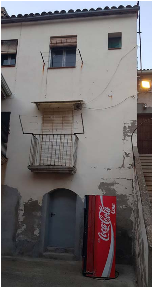
Façana Sud, escales a la dreta per accés al pis de planta segona
