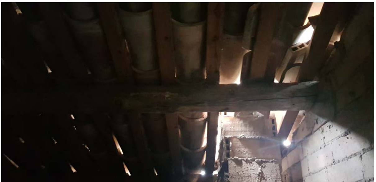
Estat de la coberta
