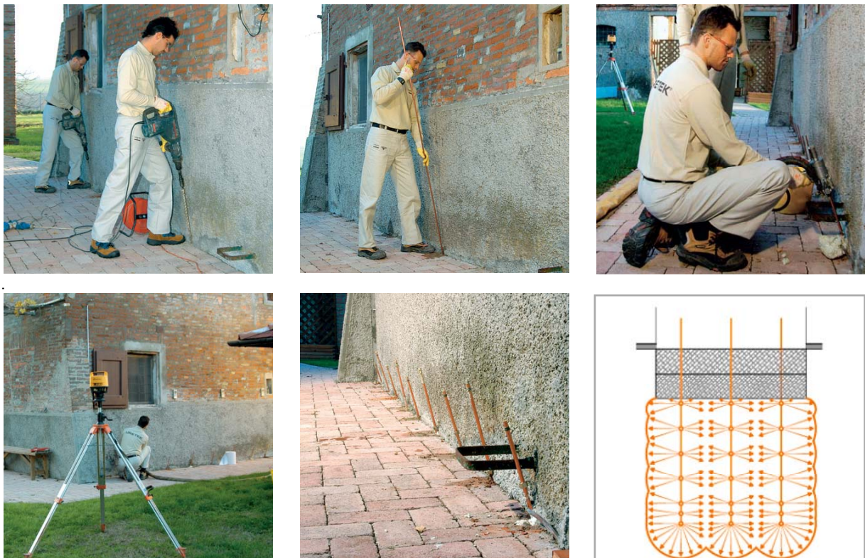
Imatge 18: Exemple del procés de consolidació amb injeccions
