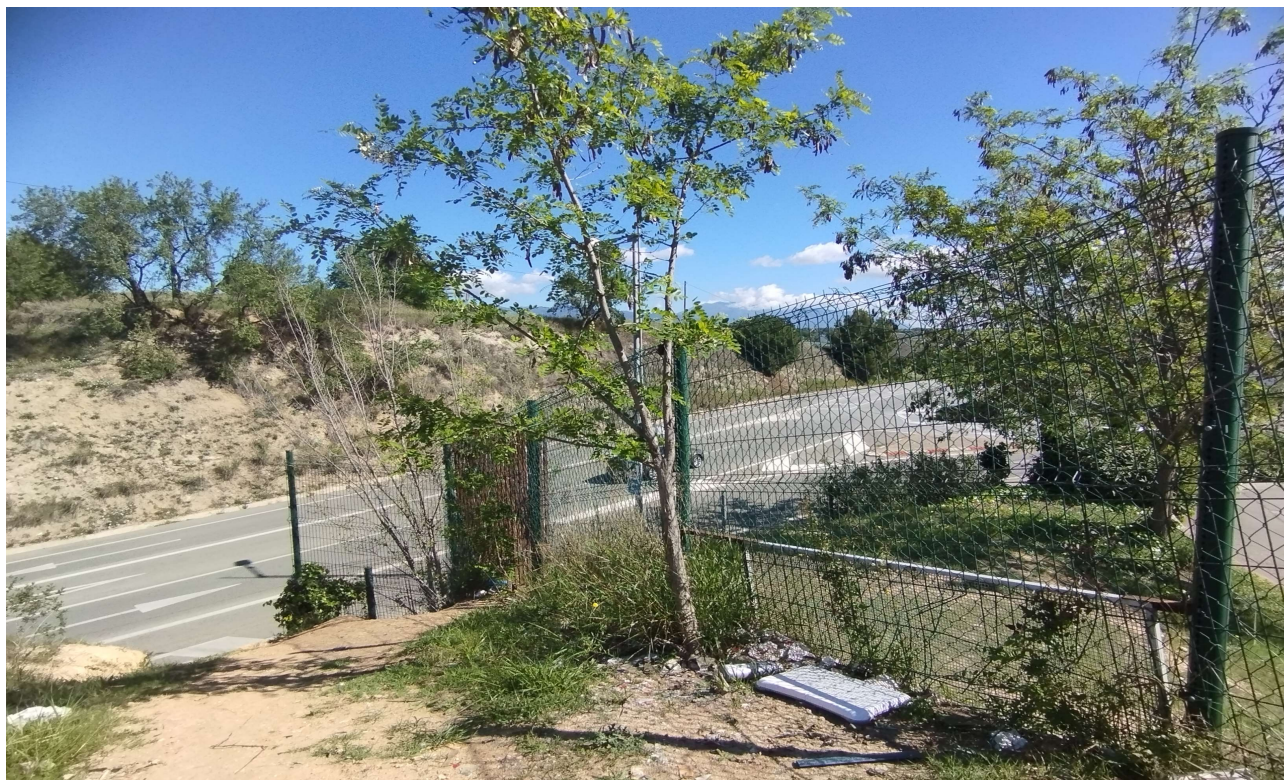
Tanca del tram Nord-Oest_zona superior
