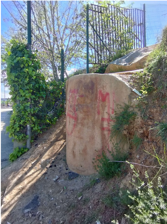
Tanca del tram Nord-Oest_vista des de cota inferior
