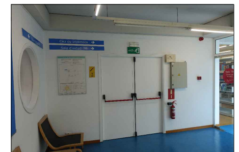
Vestíbul NORD Biblioteca
