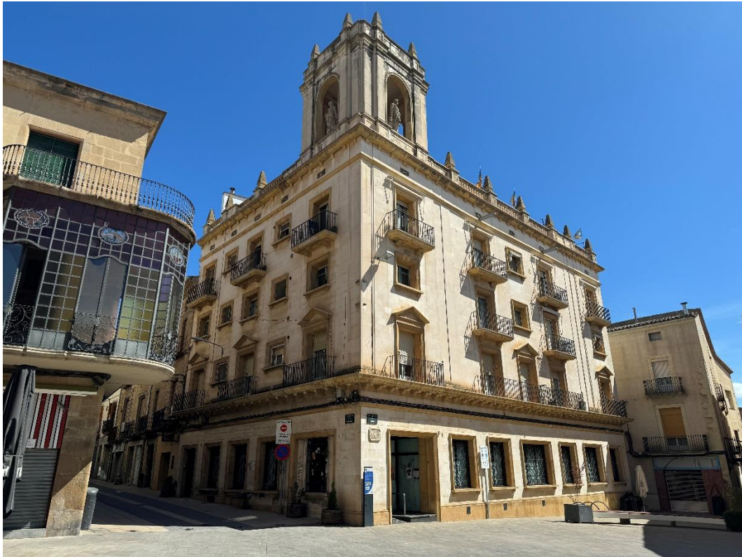
Imatge general de l'edifici: cantonada del C/ Agoders amb la Plaça Major
