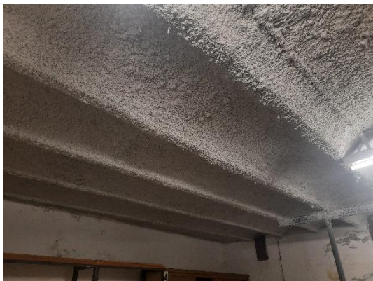
Sostre de la pl. soterrani, ignifugat (sala 1)
