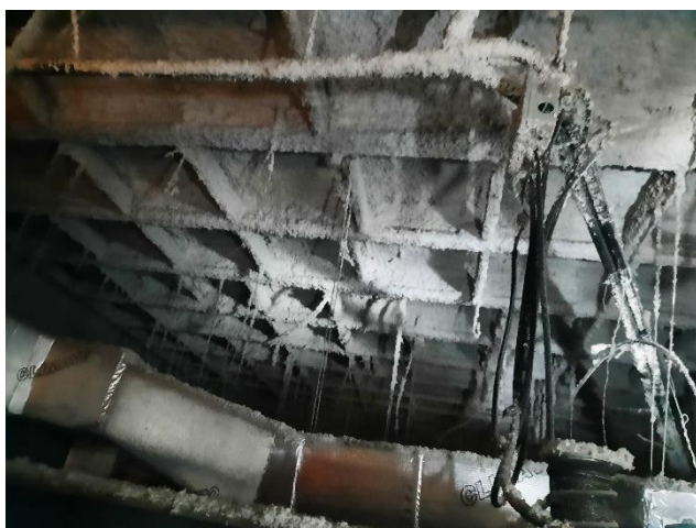
Sostre de la pl. baixa, ignifugat
