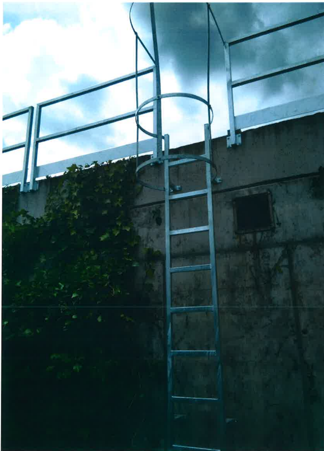
MODEL TIPUS D'ACCÉS DE MANTENIMENT DE DIPÒSIT D'AIGUA
