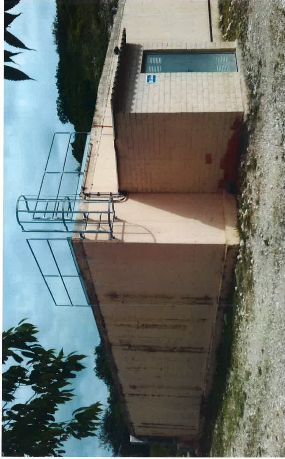
MODEL TIPUS D'ACCÉS DE MANTENIMENT DE DIPÒSIT D'AIGUA
