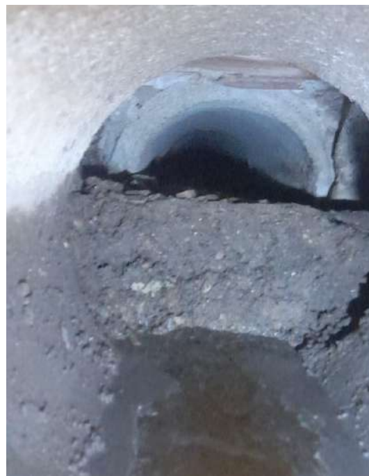
Fotografia cala: interior del tub de col·lector de formigó
