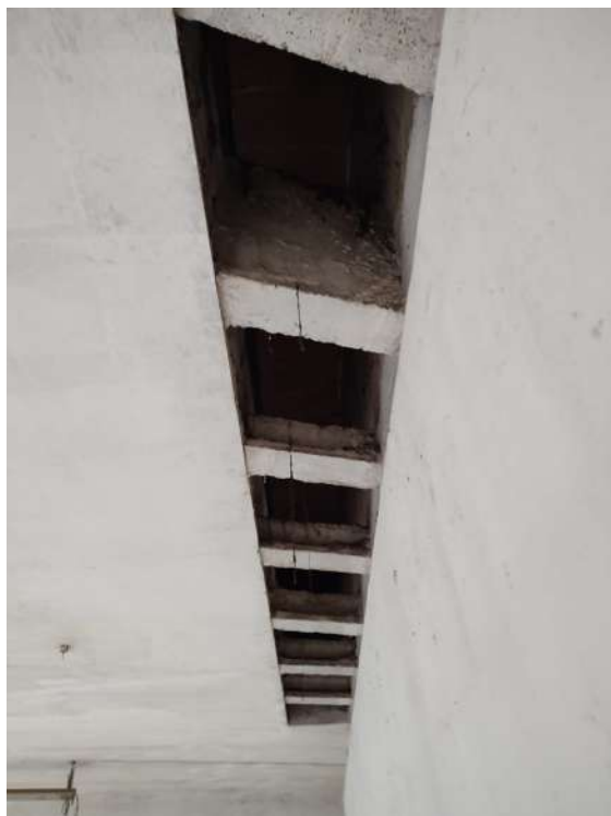
Foto 6: Ventilació existent entre el local i les terrasses
