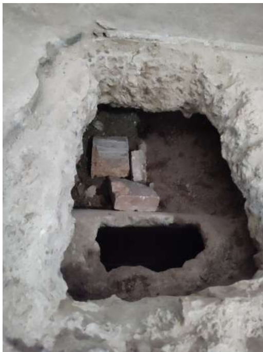
Fotografia cala: exterior del col·lector de formigó
