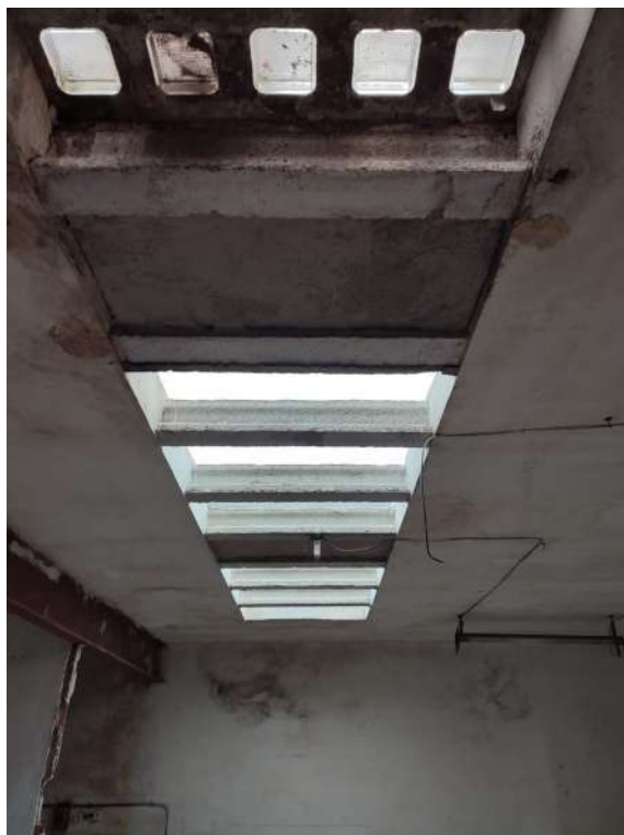
Foto 5: Lluernaris en forjat de terrasses (elements comuns privatis)
