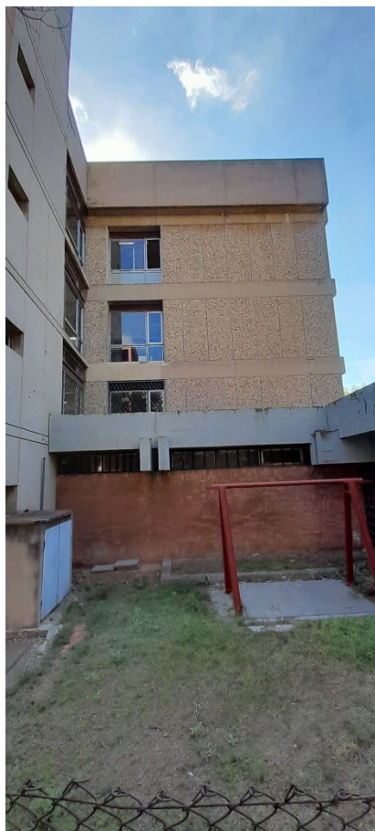
Torre 2 – Façana nord-oest
