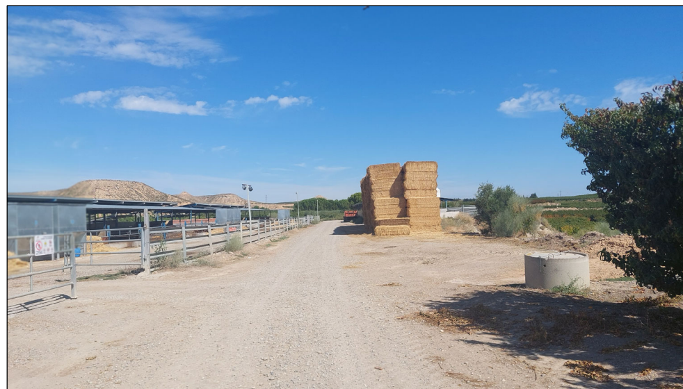
Fotografia Georeferenciada, Camí i embornal de recollida d'aigües existent, vista en sentit cap a l'inici del camí pk: 1+070
