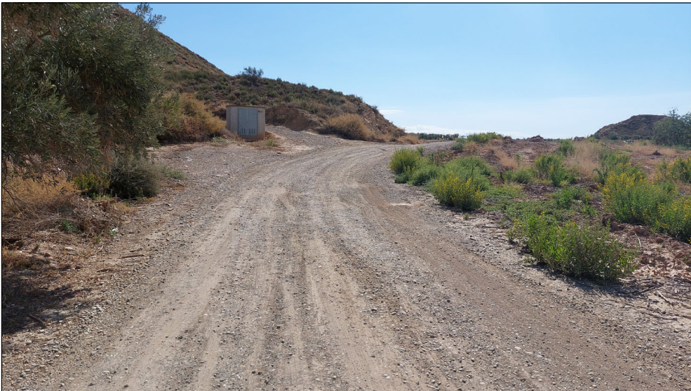
Fotografia Georeferenciada,En sentit contrari pk: 1+600
