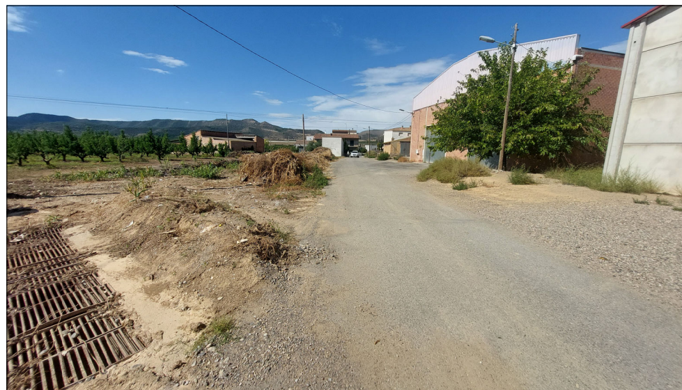
Fotografia Georeferenciada, Camí i embornal de recollida d'aigues existent, vista en sentit cap a l'inici del camí pk: 0+095
