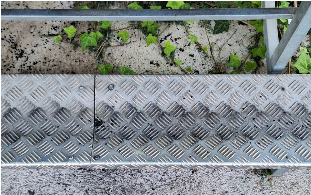
Substitució de planxa llagrimada existent i nou reforç central
