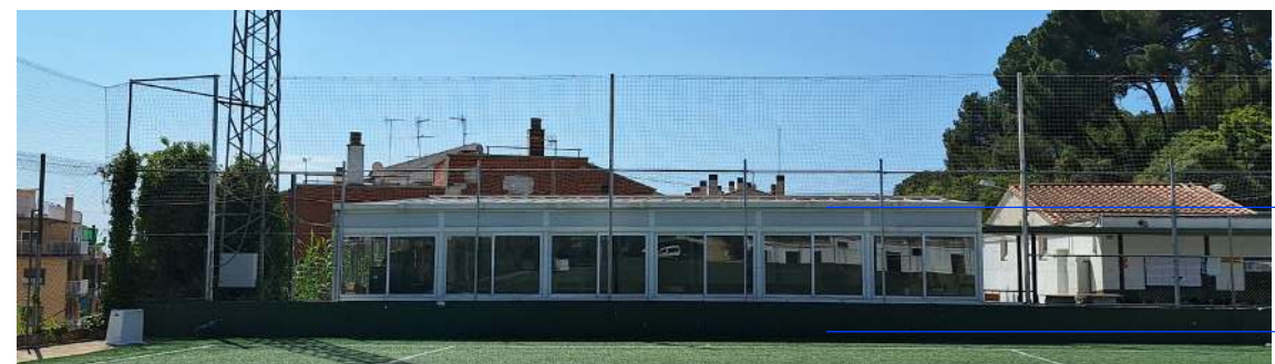
Enretirar malla i xarxa existents i els seus elements de suport
