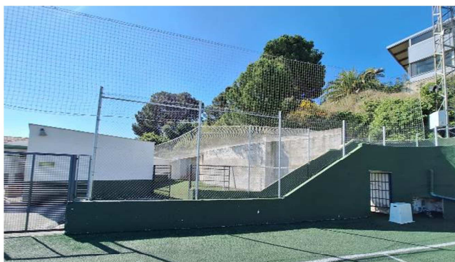
Xarxes i malla de protecció a substituir
