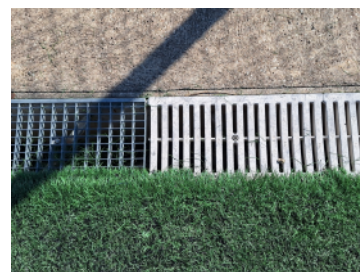
(03) Enretirada de reixes de canal existent
