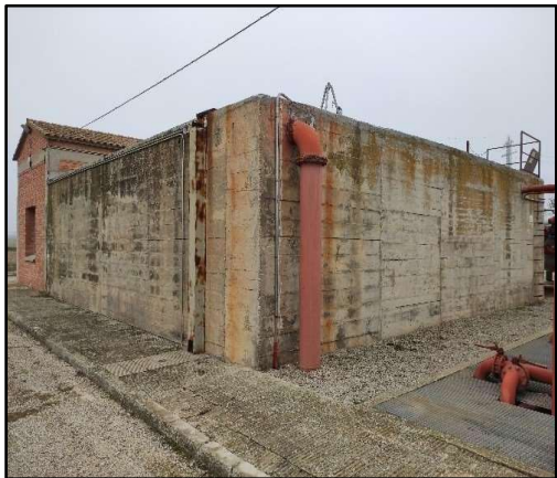
1. imatge de l'exterior del dipòsit
