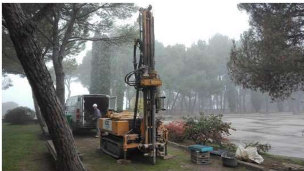
Foto-3: Vistaparcial de la zona a edificar. Ubicació de sondeig S-3.
