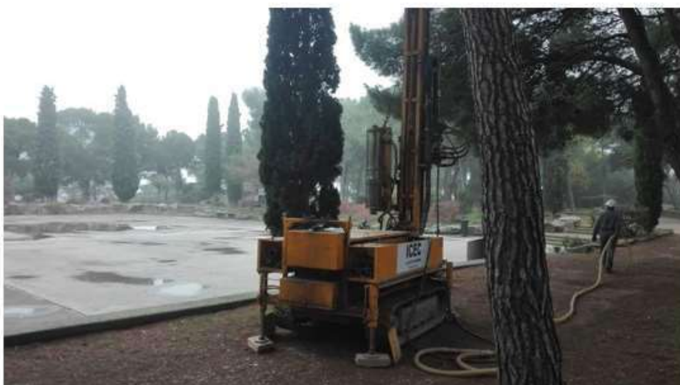
Foto-4: Vistaparcial de la zona a edificar. Ubicació de sondeig S-4.
