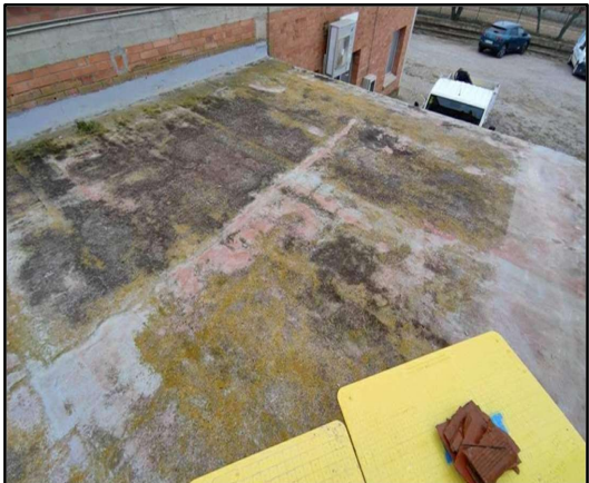
4. estat exterior coberta
