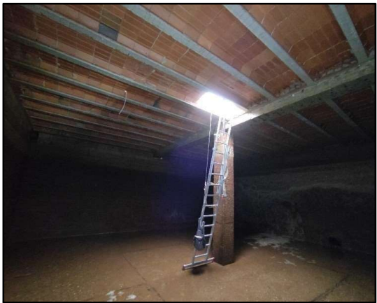
2. accés a l'interior del dipòsit i pilar central
