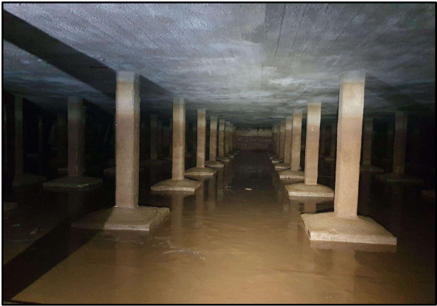
2. pilars interiors del dipòsit
