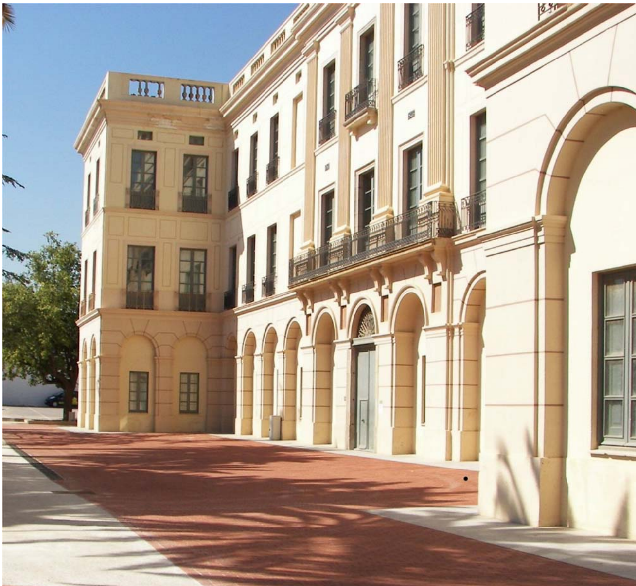
Façana Sud – Oest
